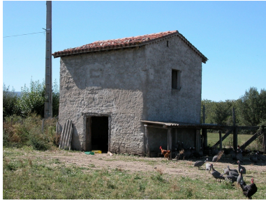
Vue générale. Phot. Thierry Monnet IVR82_20124201560NUCA
