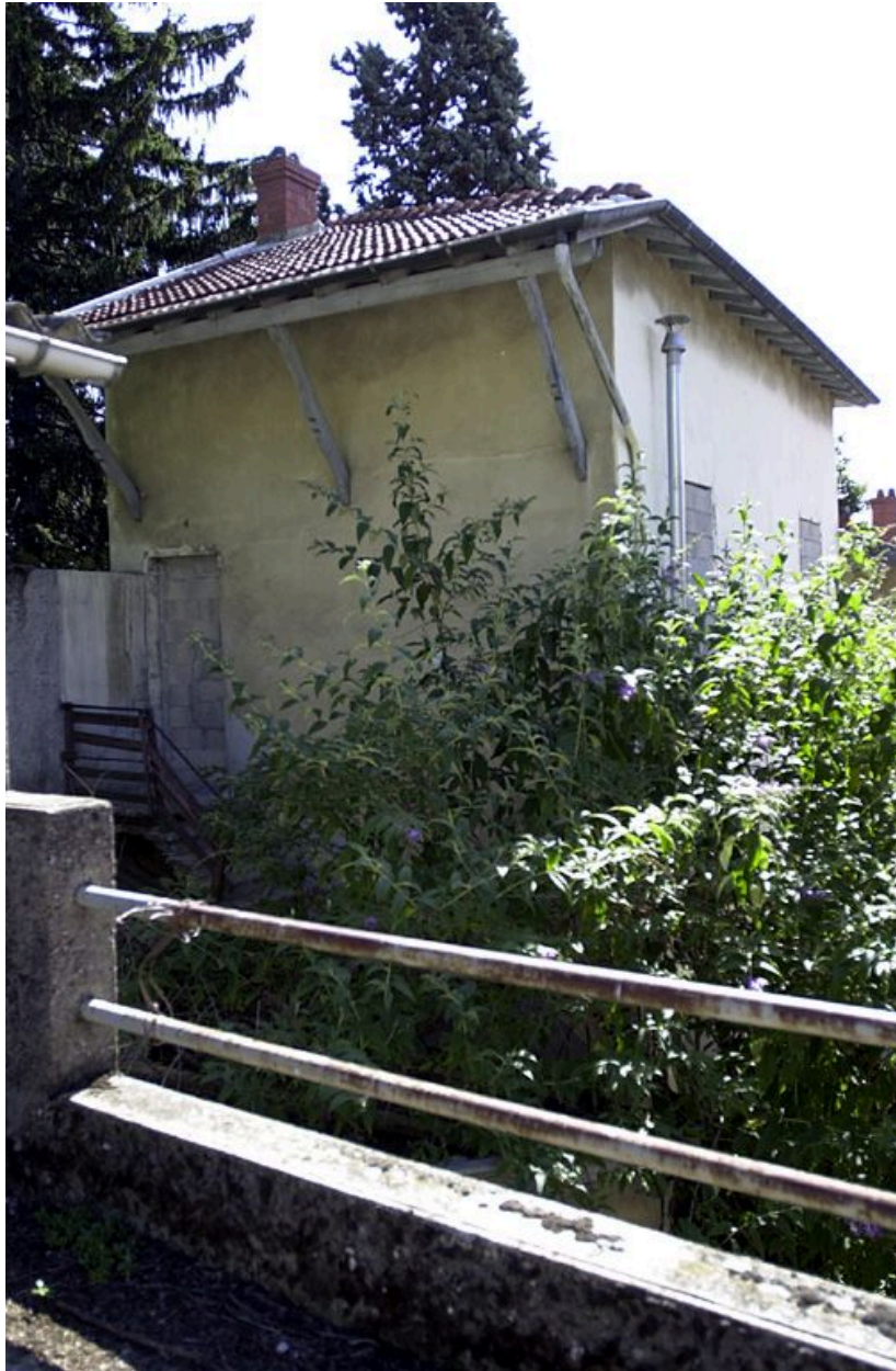
Détail du corps de bâtiment ouest, depuis le boulevard de la Duchère
