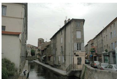
Vue d'ensemble du côté du Vizézy. Phot. Simone Hartmann-Nussbaum IVR82_20124201235NUCA
