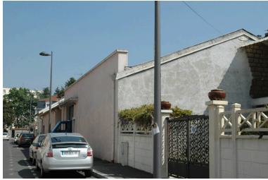
Vue générale. Façade principale, vue sud. Phot. Nadine Halitim-Dubois IVR82_20096901781NUCA
