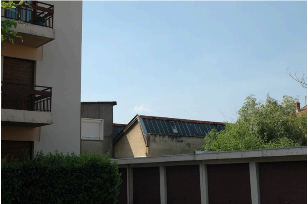
Façade arrière, vue nord est. Détail des toits en sheds.
