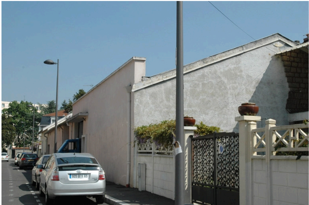
Vue générale. Façade principale, vue sud.
