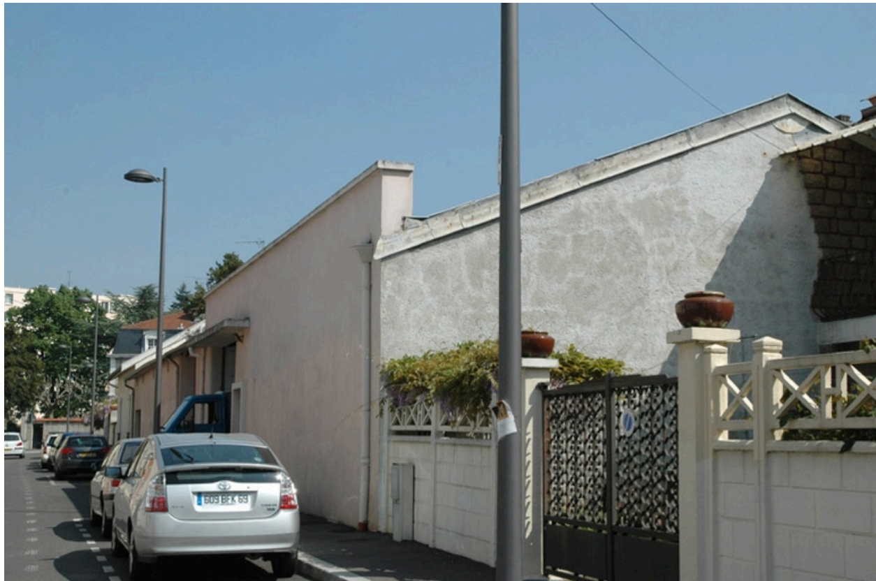
Vue générale. Façade principale, vue sud.
