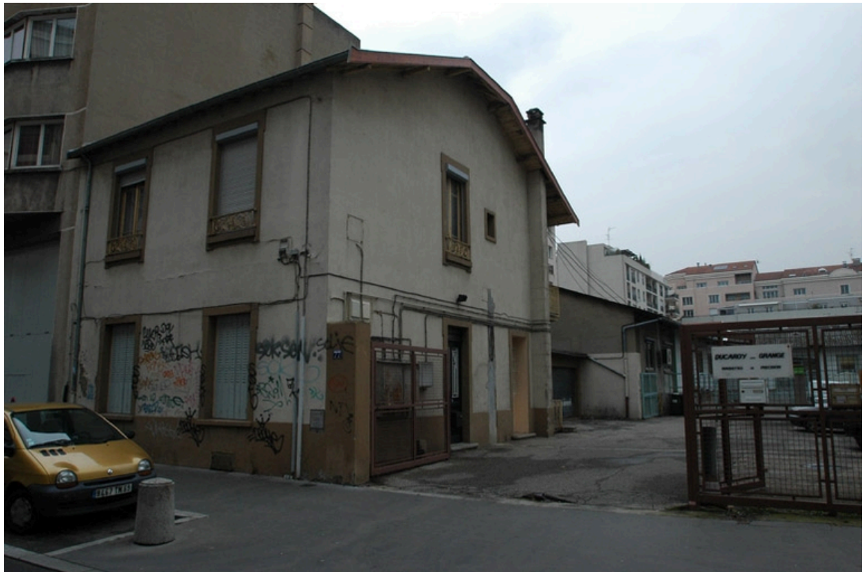
Vue générale sud est, façade et entrée rue Etienne Richerand.
