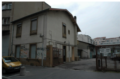
Vue générale sud est, façade et entrée rue Etienne Richerand. Phot. Nadine Halitim-Dubois IVR82_20096901749NUCA
