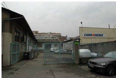
Ateliers sur cour, vue ouest. Phot. Nadine Halitim-Dubois IVR82_20096901748NUCA
