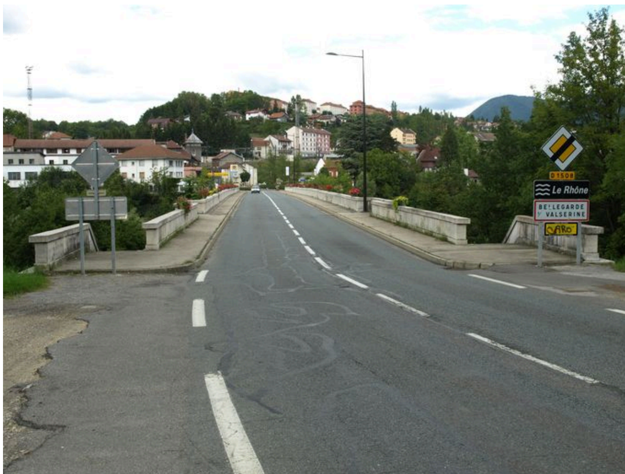
Vue générale, de dessus, chaussée et accès aux escaliers de la culée droite (depuis la rive droite)
