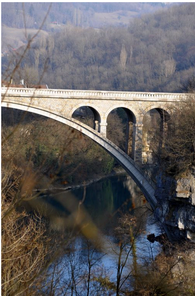
Vue partielle, moitié gauche de l'arche centrale, face aval (depuis la rive droite)
