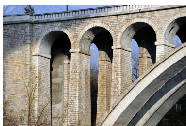
Partie droite de l'arche centrale, face aval, vue de détail : dédoublement des petites arches Phot. G. Gellert IVR82_20100100393NUCA
