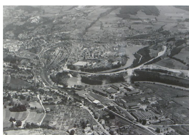
[Bellegarde-sur-Valserine. Vue générale, pont de Savoie] / Roger Henrard phot., 1945-1960. 1 fotogr. pos. : n. et b. ; 18 x 24 cm (AD Ain. Fonds Henrard, 14 Fi 10) Phot. F. Bardoneschi, Autr. Roger (photographe) Henrard IVR82_20100100027NUCAB
