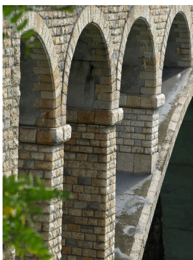
Partie droite de l'arche centrale, face aval, vue de détail : appareil des petites arches (depuis la rive droite) Phot. B. Decrock IVR82_20100100394NUCA
