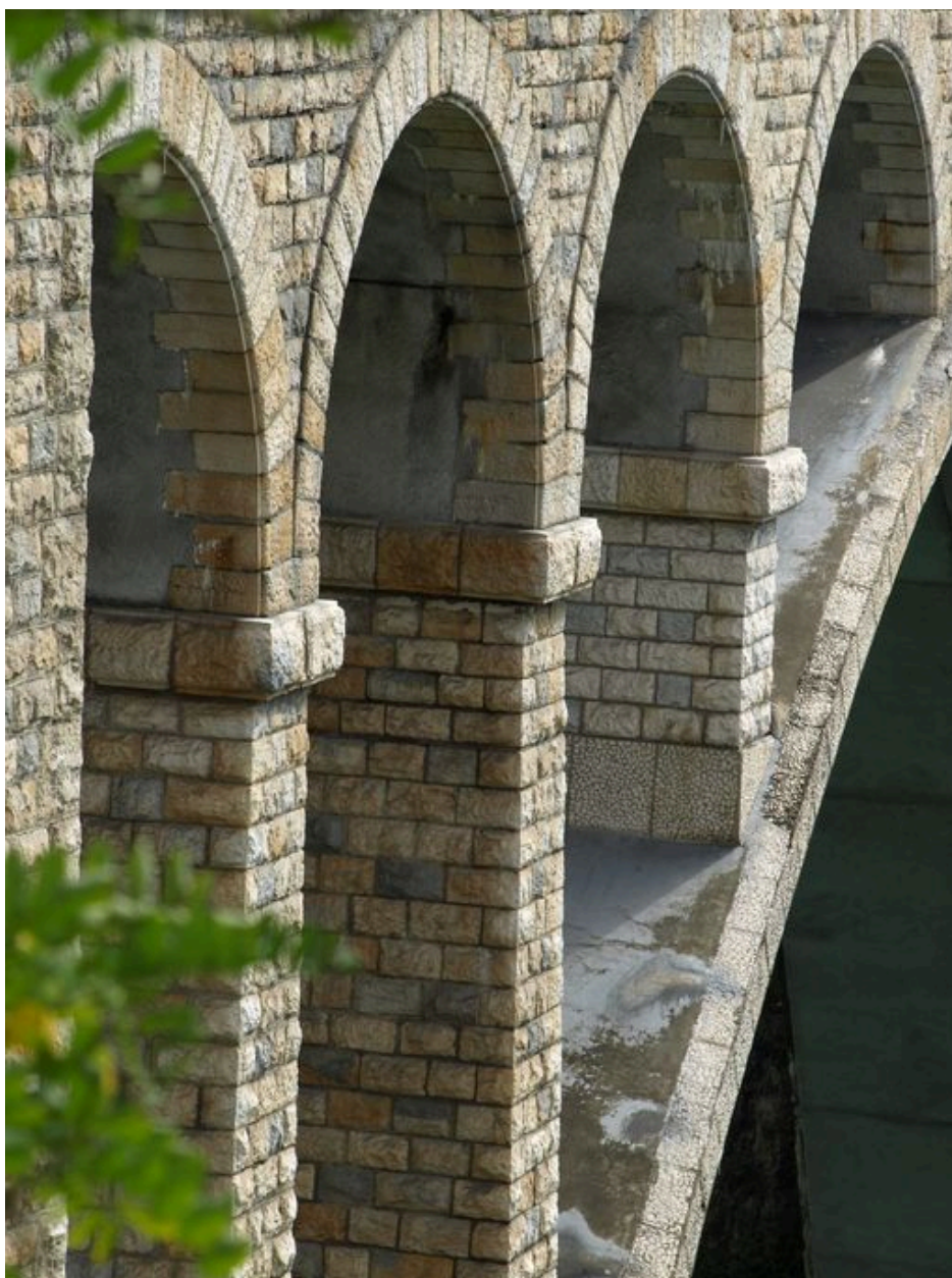
Partie droite de l'arche centrale, face aval, vue de détail : appareil des petites arches (depuis la rive droite)
