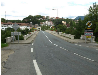
Vue générale, de dessus, chaussée et accès aux escaliers de la culée droite (depuis la rive droite) Phot. B. Decrock IVR82_20100100395NUCA
