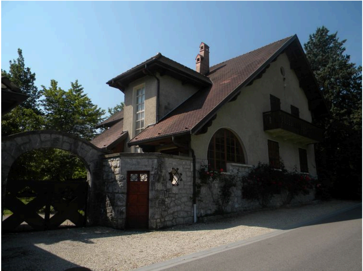
Vue d'ensemble d'une maison bourgeoise près de Loche (2008 A2 1223).
