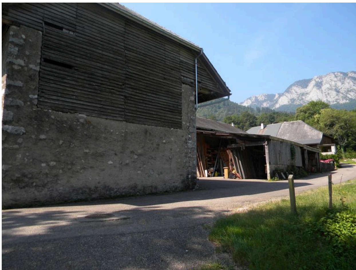
Vue générale de Loche.
