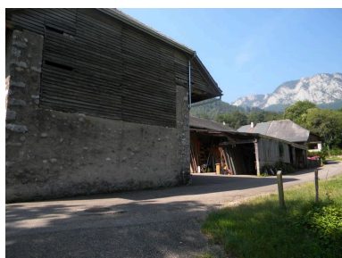
Vue générale de Loche. Phot. Jérôme Daviet IVR82_20127400622NUCA
