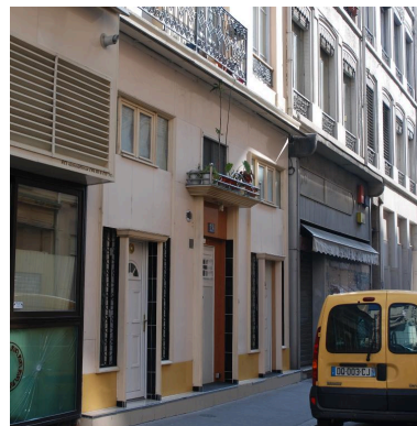
Détail de l'élévation sur rue Montesquieu : logement indépendant en rez-de-chaussée Phot. Catherine Guégan IVR84_20166900532NUCA
