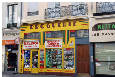
Détail de l'élévation sur rue de Marseille : devanture de droguerie Phot. Catherine Guégan IVR84_20166900530NUCA
