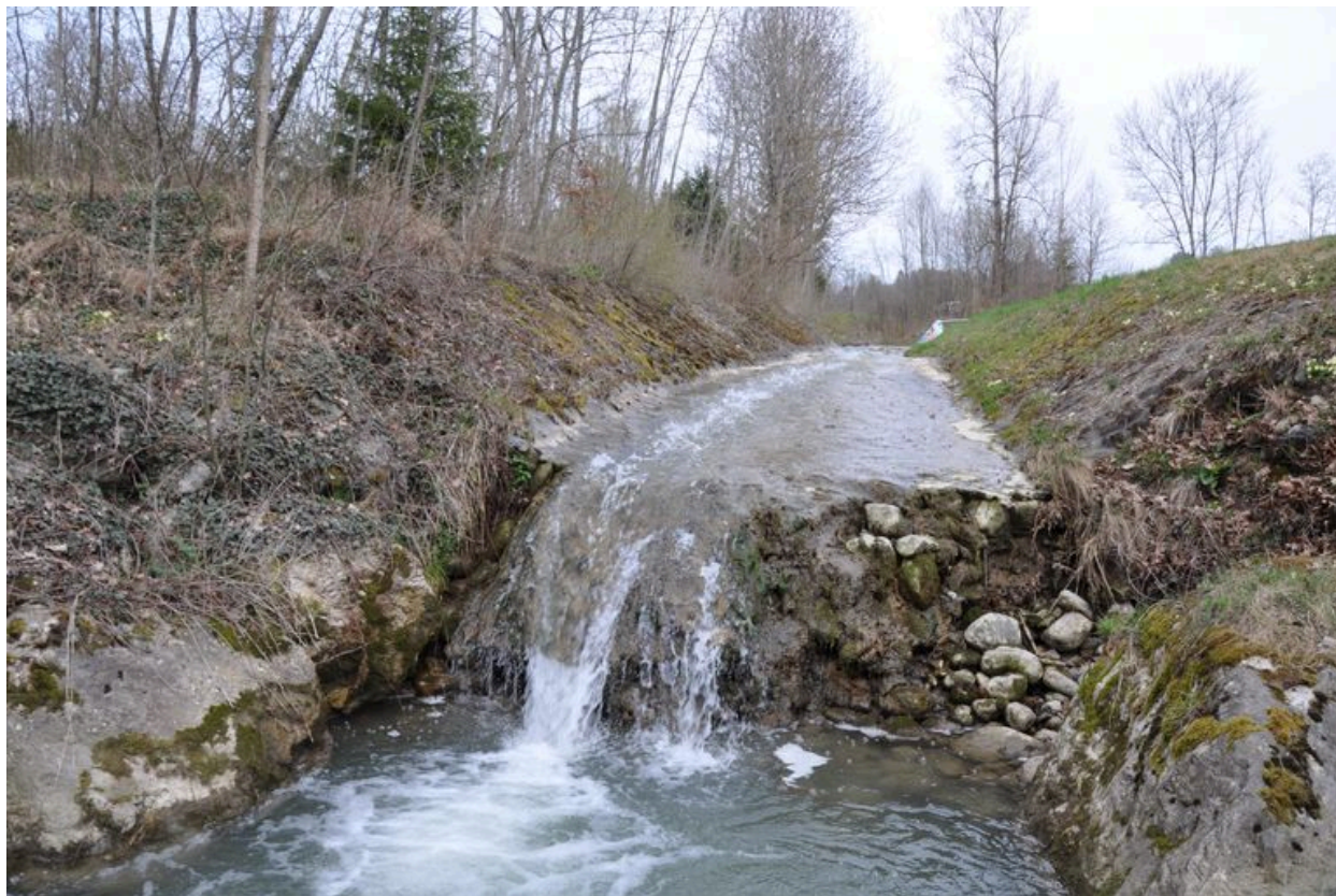
Radier du ruisseau des Tavernettes au passage de l'ancien aqueduc du bief du moulin
