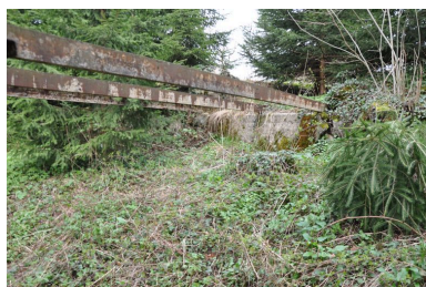
Structure métallique de l'ancienne passerelle enjambant le bief du moulin
