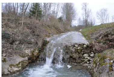
Radier du ruisseau des Tavernettes au passage de l'ancien aqueduc du bief du moulin Phot. Samir Mahfoudi, Autr. Samir Mahfoudi IVR82_20107400163NUCA
