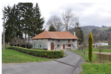
Vue générale Phot. Samir Mahfoudi, Autr. Samir Mahfoudi IVR82_20107400162NUCA
