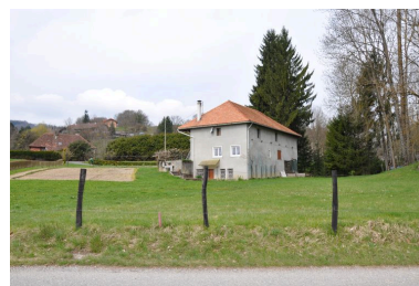
Elévation est du bâtiment du moulin Phot. Samir Mahfoudi, Autr. Samir Mahfoudi IVR82_20107400168NUCA
