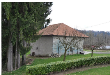
Elévation ouest du bâtiment du moulin Phot. Samir Mahfoudi, Autr. Samir Mahfoudi
