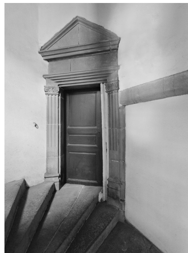
Porte palière de l'escalier en vis accessible par la rue Chevenotterie. Phot. Didier Gourbin IVR82_20064201983V
