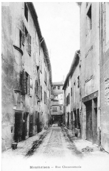
Montbrison - Rue Chenevotterie. Carte postale, début 20e siècle (?). Au 1er plan à gauche, l'escalier demi-hors-oeuvre. Phot. Eric (reproduction) Dessert IVR82_20054201647NUCB
