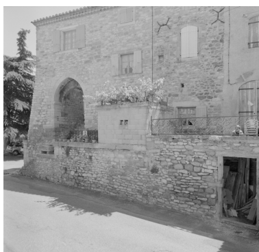
La porte de la Fontaine et les maisons construites dans le mur d'enceinte du village. Phot. Alain Franchella IVR82_19992600233X
