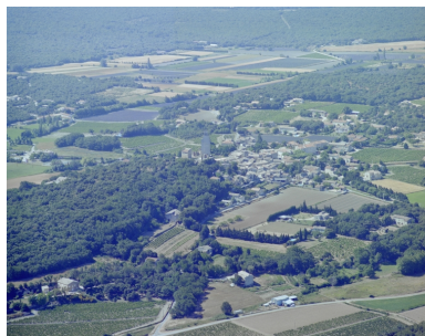
Vue aérienne. Phot. Alain Franchella IVR82_20002601262XE
