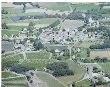
Vue aérienne, prise de l'ouest. Phot. Alain Franchella IVR82_20002601261XE
