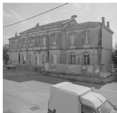
Le village : élévation principale de la mairie-école, aujourd'hui école. Phot. Alain Franchella IVR82_19992600165X
