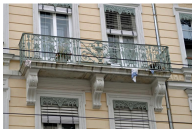
Détail : balcon au 2ème étage, élévation antérieure Phot. Magali Delavenne IVR84_20186900882NUCA
