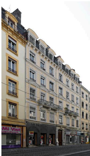
Elévation antérieure, rue de Marseille Phot. Eric Dessert IVR84_20176900450NUCAQ
