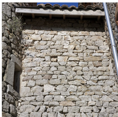
Mur construit à l'arrière de celui de la maison forte, entre la tour
