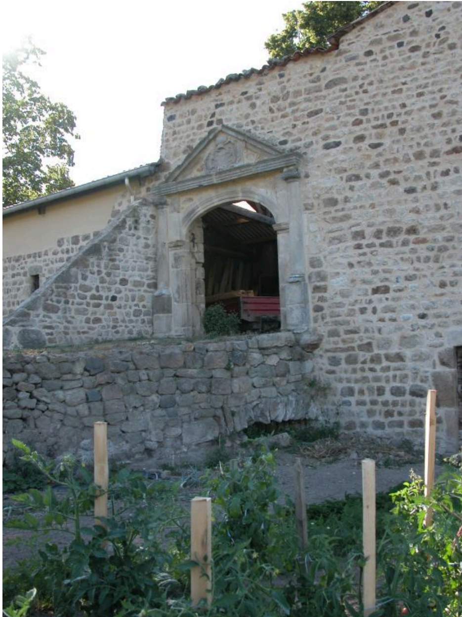
Entrée de la maison forte, vue d'ensemble du portail.
