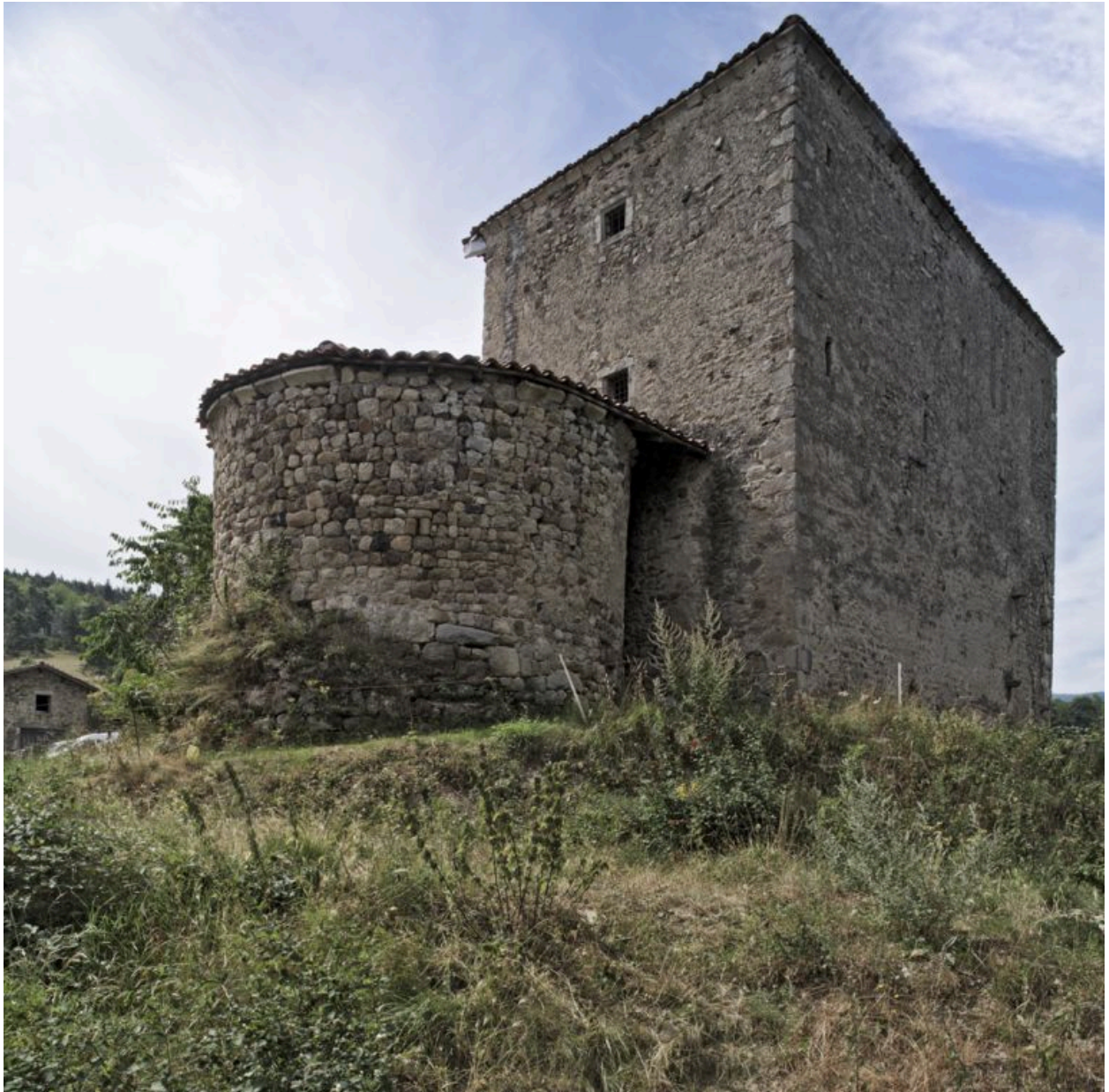
Vue d'ensemble depuis le nord-est du corps de bâtiment est et de la chapelle.
