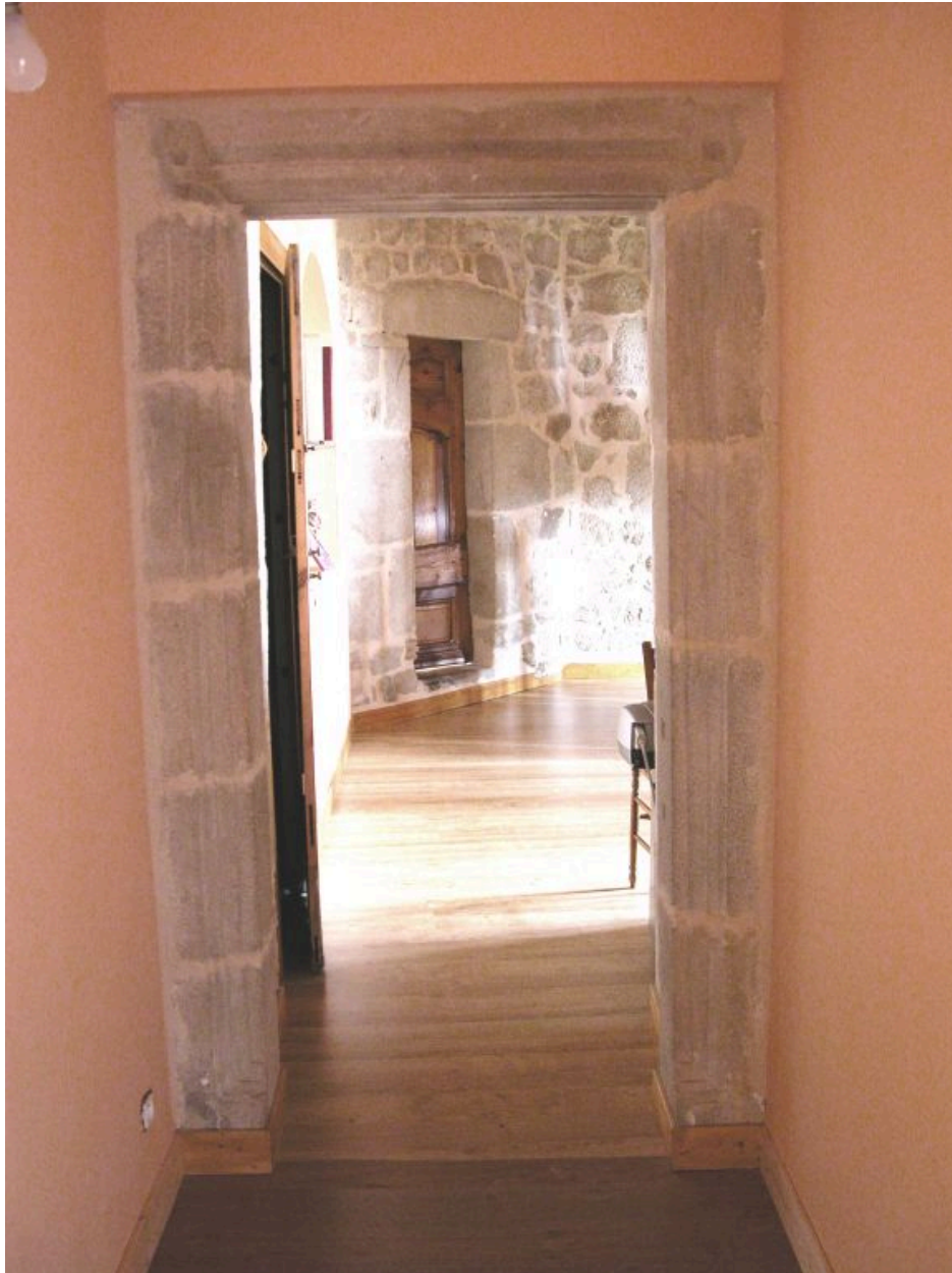
Aile nord de la maison forte, première pièce de l'étage carré située à droite de la cage d'escalier centrale : vue d'ensemble de la porte à encadrement mouluré située au nord et permettant d'accéder à la pièce adjacente.
