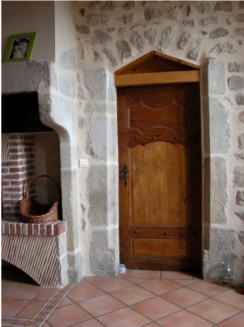
Aile nord de la maison forte, première pièce du rez-de-chaussée située à droite de la cage d'escalier centrale : vue d'ensemble de la porte située à droite de la cheminée et ouvrant sur la pièce adjacente.
