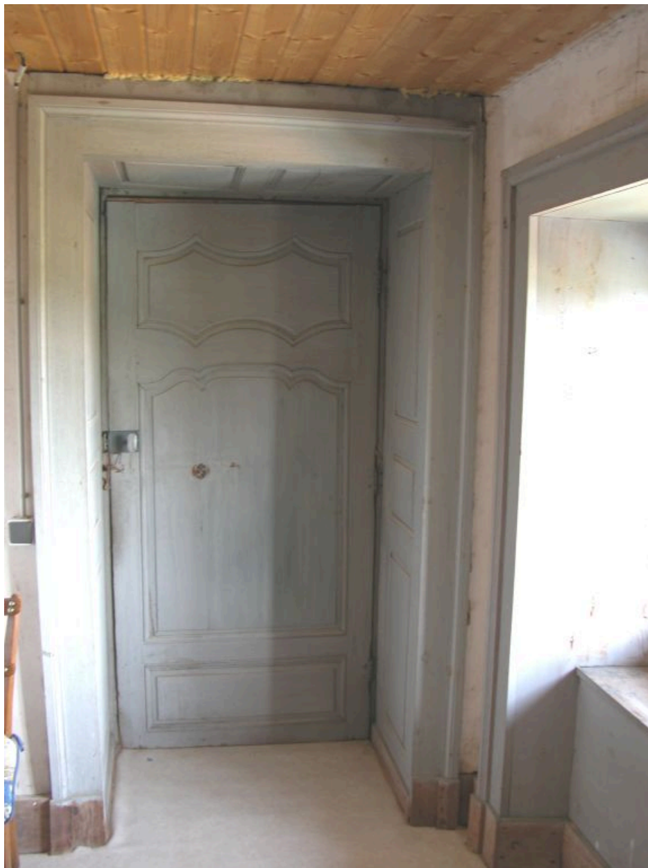
Aile nord de la maison forte, première pièce de l'étage de comble à surcroît située à gauche de la cage d'escalier centrale : vue d'ensemble de la porte sud permettant de communiquer avec la pièce adjacente.
