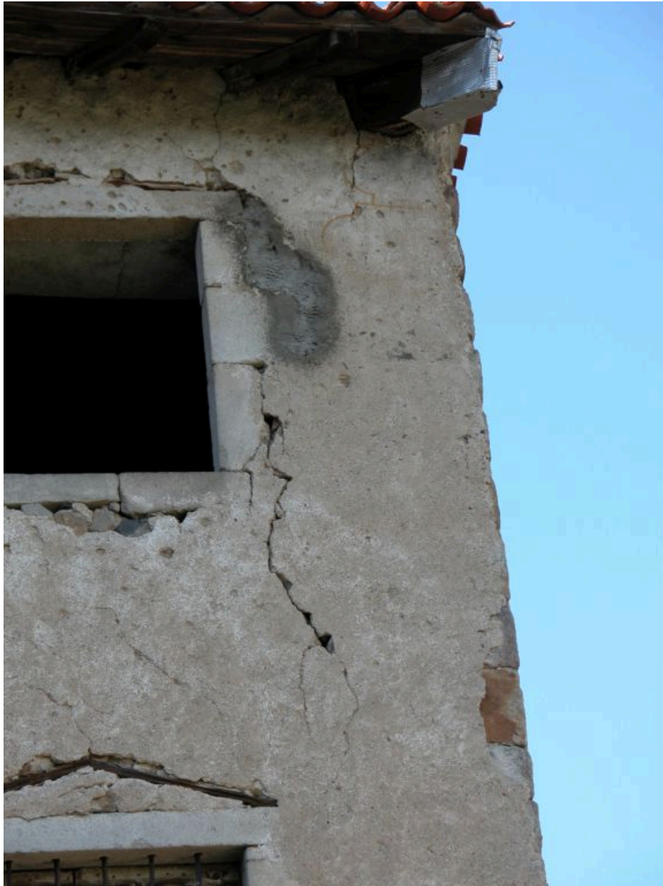
Corps de bâtiment est de la maison forte, angle sud-ouest : détail du décor peint du chaînage d'angle.
