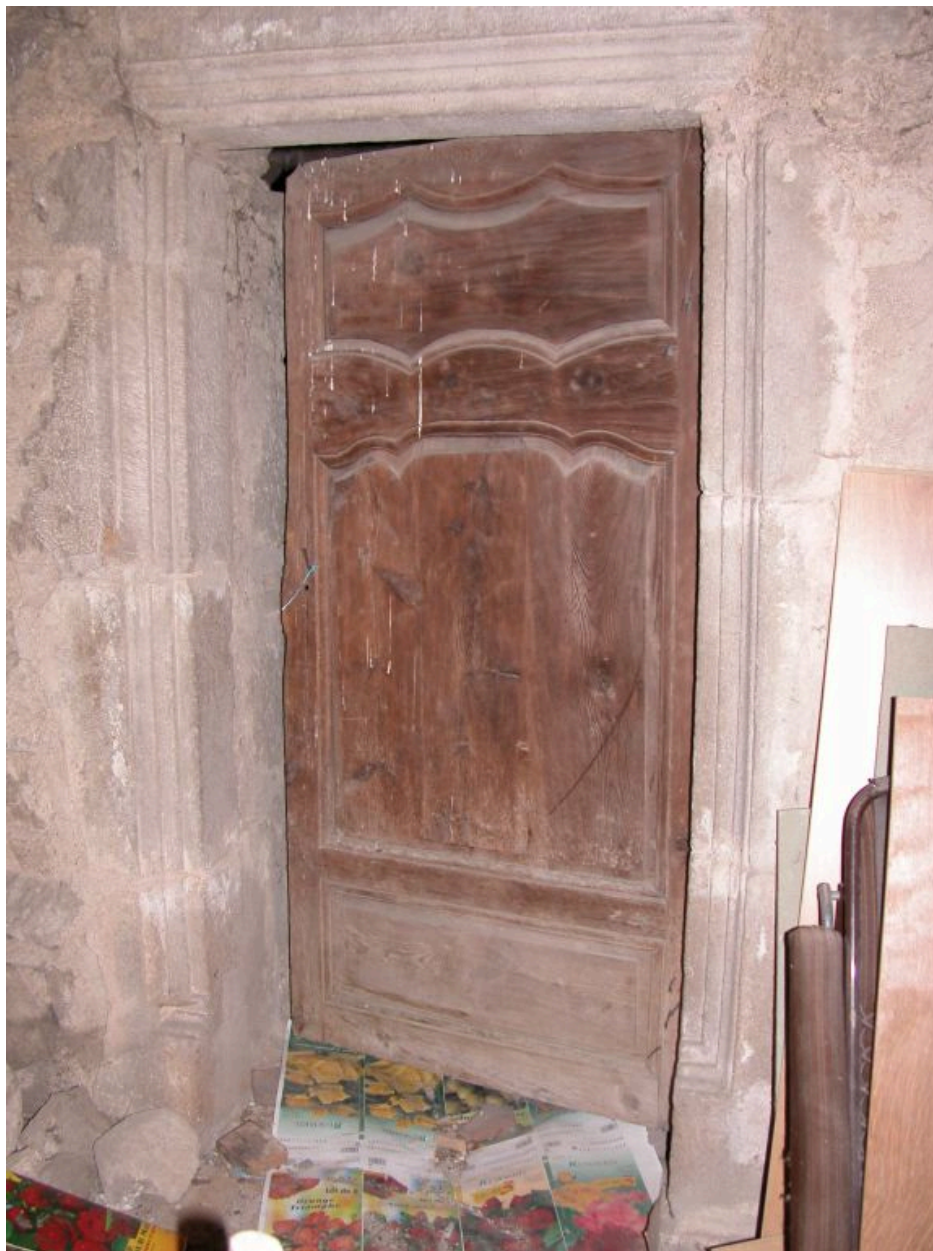
Aile nord de la maison forte, seconde pièce de l'étage de comble à surcroît située à gauche de la cage d'escalier centrale : vue d'ensemble de la porte à encadrement mouluré ouvrant dans la tour d'angle nord-ouest.
