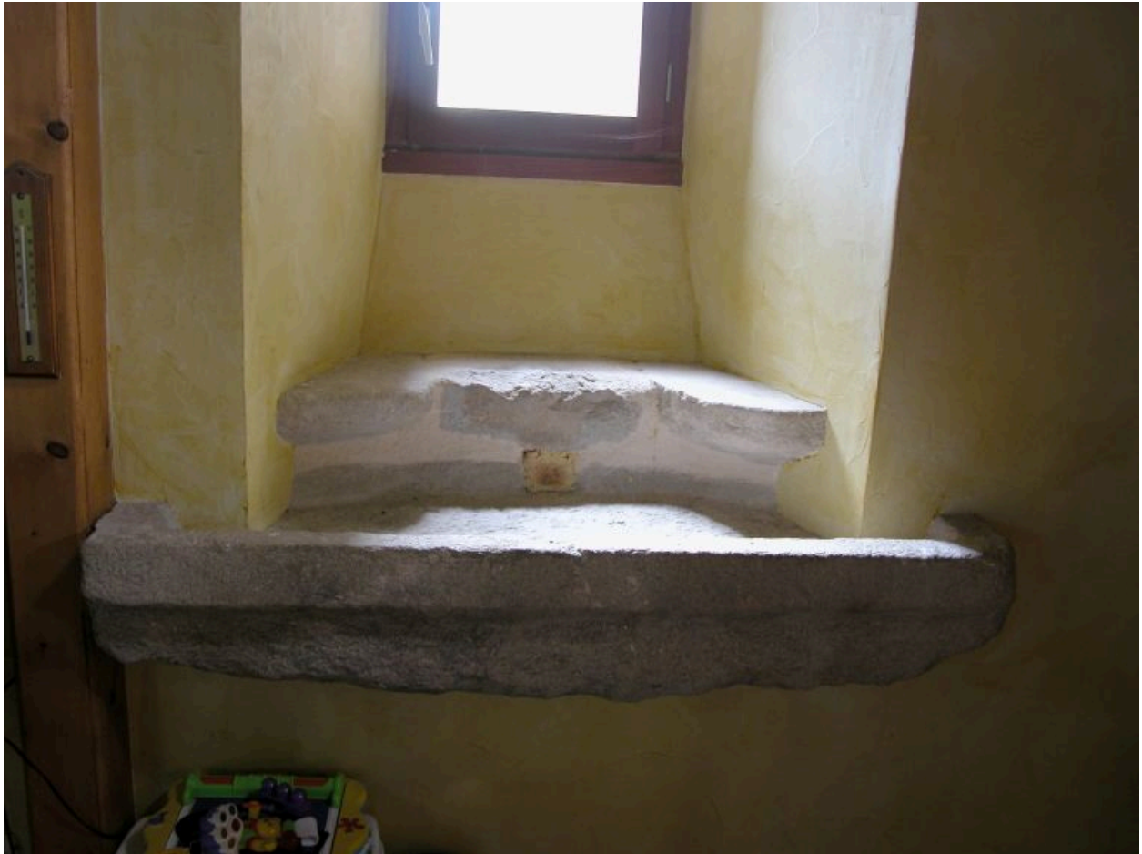
Aile nord de la maison forte, seconde pièce du rez-de-chaussée située à droite de la cage d'escalier centrale : vue d'ensemble de l'évier en pierre situé face à une petite fenêtre ouvrant sur le mur pignon est.
