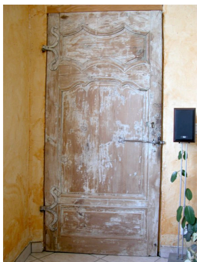
Aile nord de la maison forte, seconde pièce de l'étage carré située à gauche de la cage d'escalier centrale : vue d'ensemble intérieure de la porte ouvrant dans la tour d'angle nord-ouest. Phot. Thierry Monnet IVR82_20124200737NUCA
