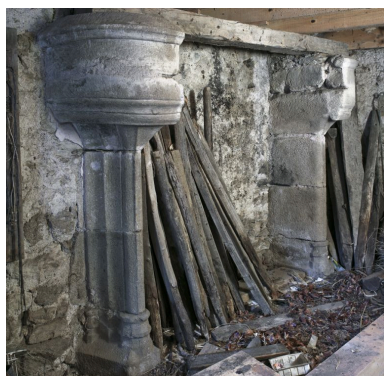
Corps de bâtiment droit encadrant le portail d'entrée : vue d'ensemble d'une cheminée monumentale du 15e siècle située au rez-de- chaussée (le linteau est manquant). Phot. Didier Gourbin IVR82_20054201981NUCA
