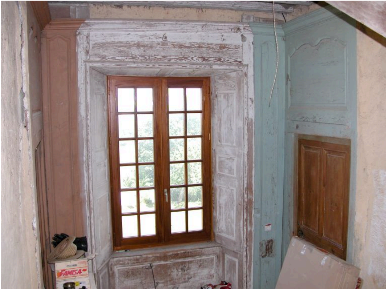
Aile nord de la maison forte, cage d'escalier centrale : vue d'ensemble de la fenêtre et des boiseries l'encadrant.
