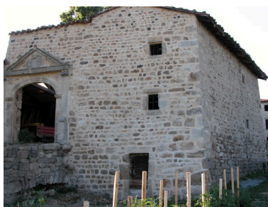
Corps de bâtiment situé au sud du portail d'entrée. Phot. Thierry Monnet IVR82_20124200714NUCA
