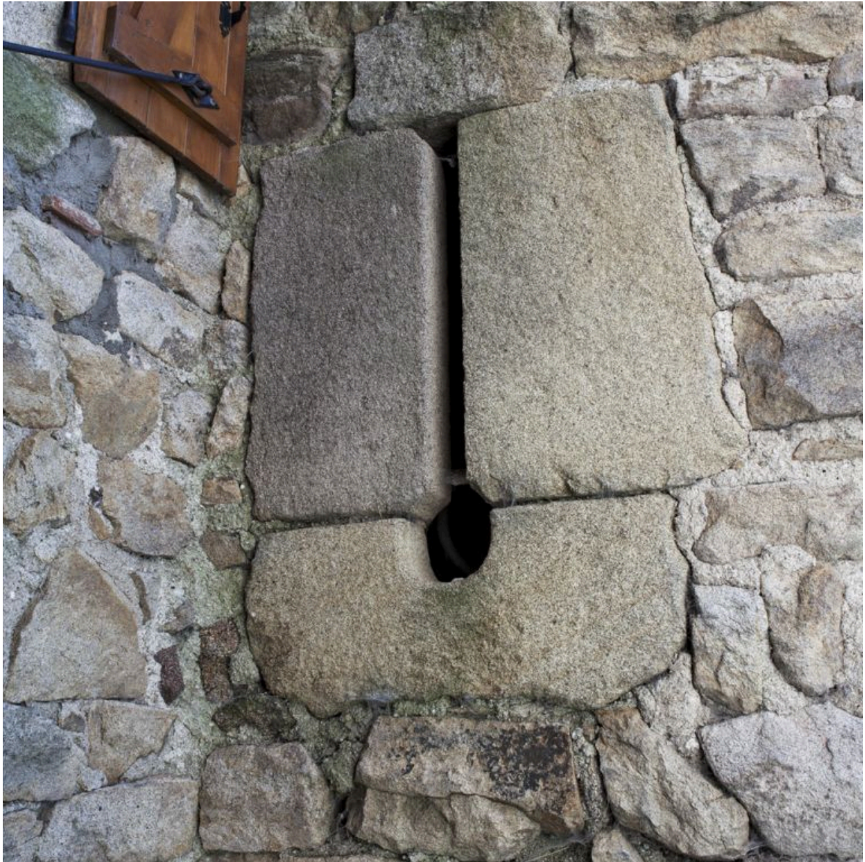
Archère-canonnière située au sud de la base de la tour nord-est de la maison forte.
