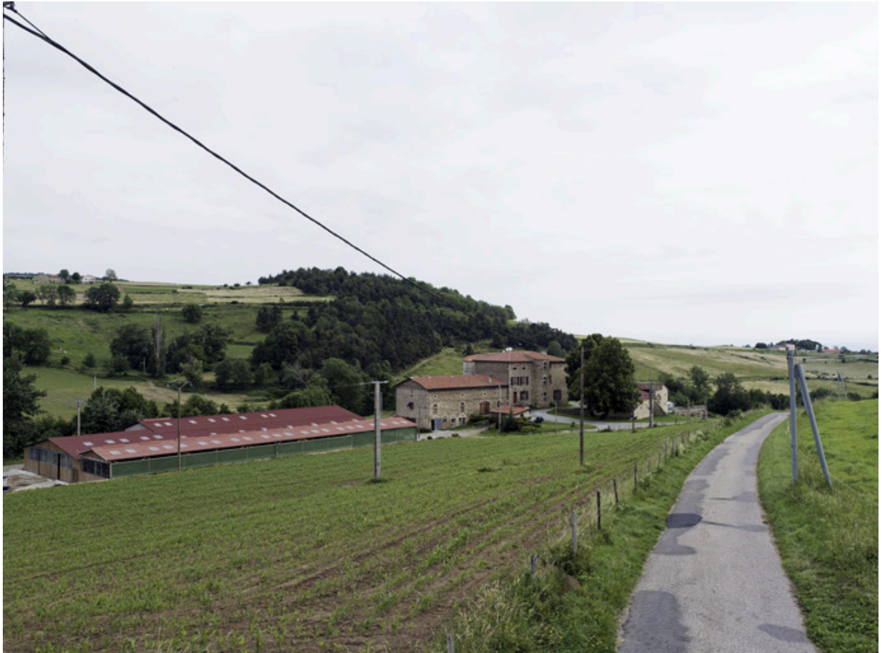
Vue générale depuis le sud-ouest.
