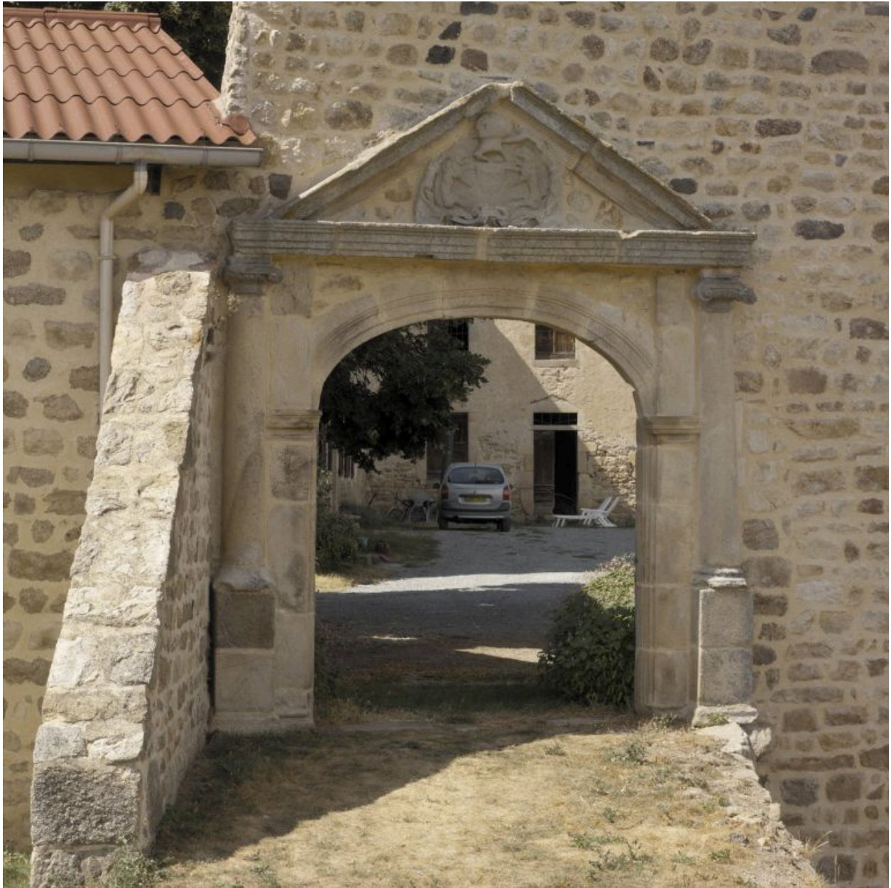
Entrée de la maison forte, vue d'ensemble du portail.
