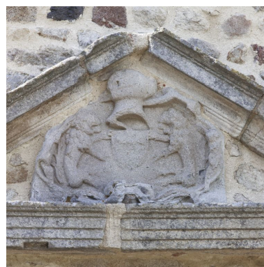
Détail du fronton triangulaire du portail d'entrée. Phot. Didier Gourbin IVR82_20054201971NUCA
