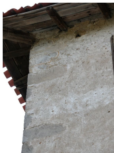
Corps de bâtiment nord de la maison forte, angle sud-ouest : détail du décor peint du chaînage d'angle Phot. Thierry Monnet
