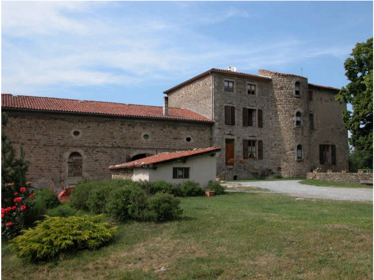
Elévation ouest de la maison forte avec la ferme à gauche de la tour.
