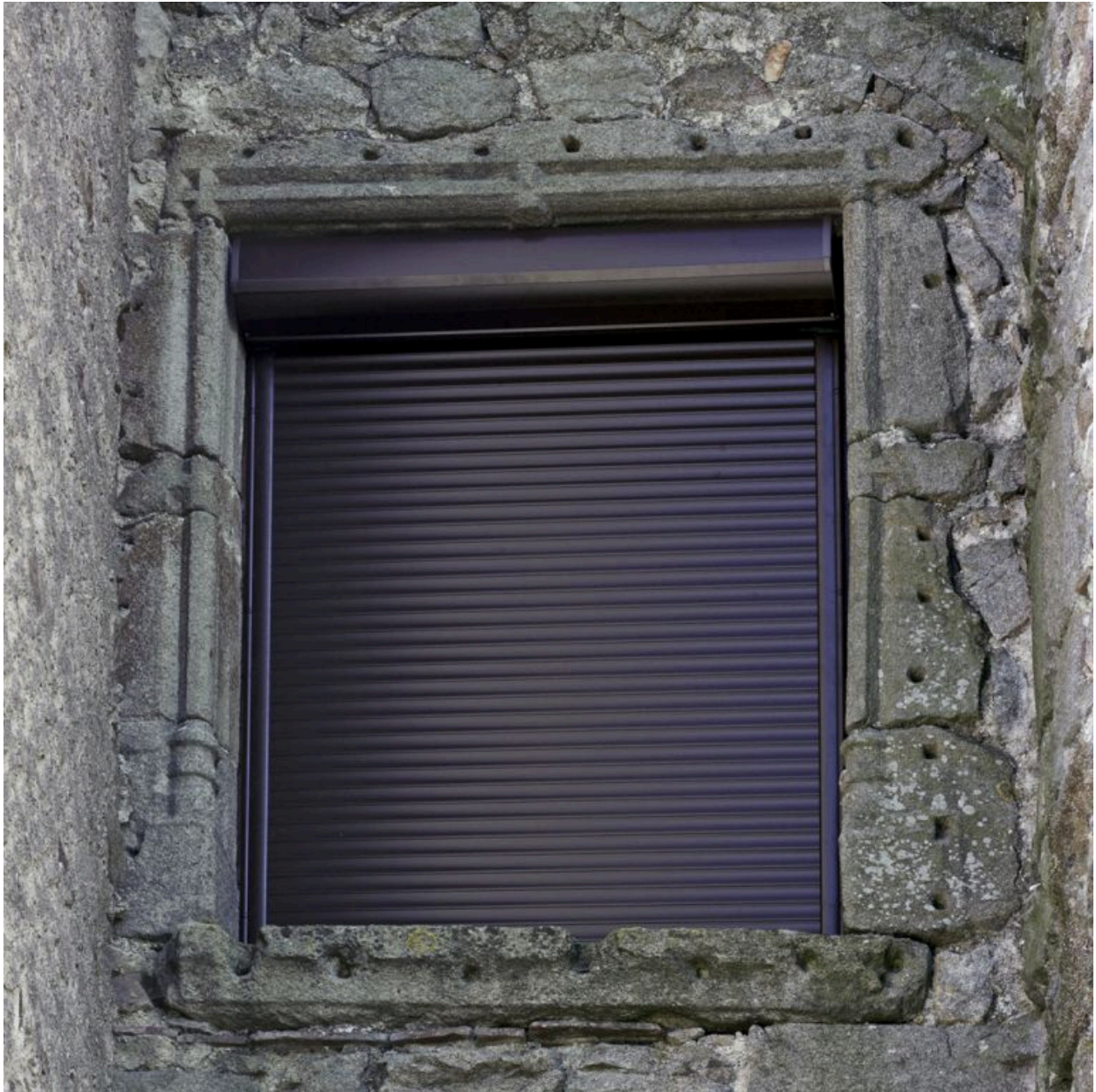
Encadrement extérieur de la fenêtre à coussiège située à l'extrémité nord-est du premier étage du bâtiment est.
