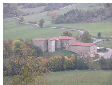
Vue d'ensemble depuis le nord. Phot. Caroline Guibaud IVR82_20124202241NUCA
