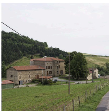
Vue d'ensemble depuis le sud-ouest. Phot. Didier Gourbin IVR82_20074200125NUCA
