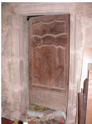
Aile nord de la maison forte, seconde pièce de l'étage de comble à surcroît située à gauche de la cage d'escalier centrale : vue d'ensemble de la porte à encadrement mouluré ouvrant dans la tour d'angle nord-ouest. Phot. Thierry Monnet IVR82_20124200738NUCA
