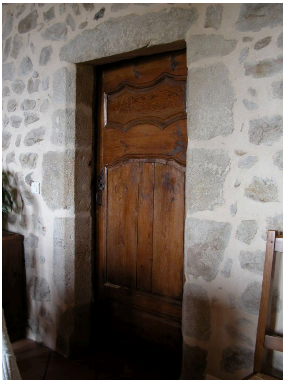
Aile nord de la maison forte, première pièce du rez-de-chaussée située à droite de la cage d'escalier centrale : vue d'ensemble de la porte d'entrée de la tour adossée à cet espace.
