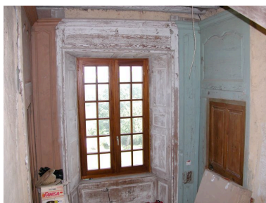
Aile nord de la maison forte, cage d'escalier centrale : vue d'ensemble de la fenêtre et des boiseries l'encadrant.
