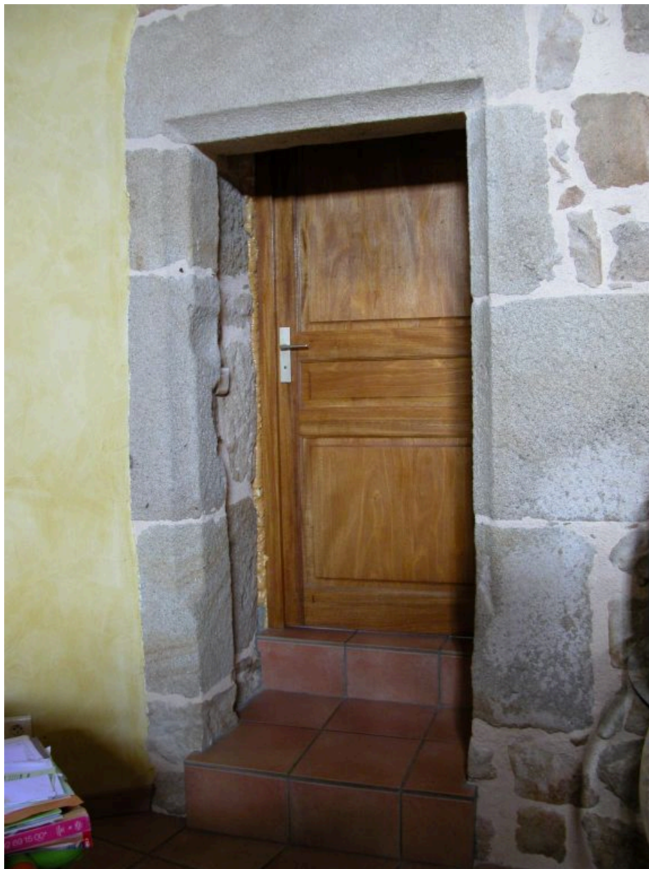
Aile nord de la maison forte, seconde pièce du rez-de-chaussée située à droite de la cage d'escalier centrale : vue d'ensemble de la porte d'entrée de la tour située dans l'angle nord-est de la pièce.
