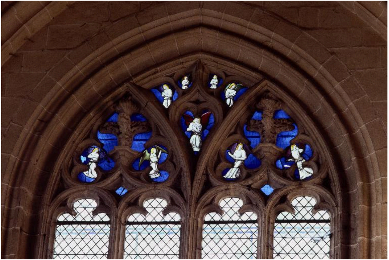
Vue sur le tympan de la baie 215
