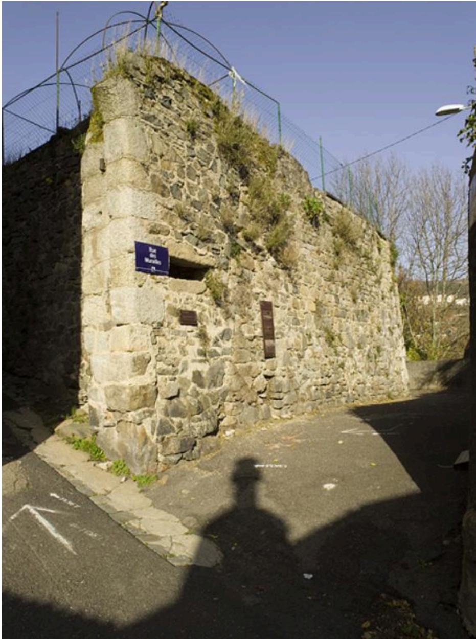
Croisement du chemin des Murailles avec la partie haute de la rue, à l'emplacement de l'ancienne porte de ville dite porte Saint-Jean.
