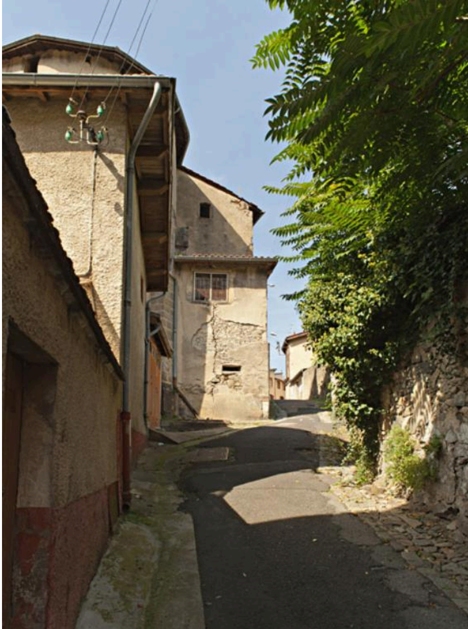
Partie haute de la rue, à proximité de l'église Saint-Jean-du-Passet.
