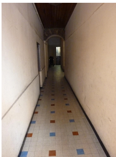
Vue de l'entrée principale Phot. Nadine Halitim-Dubois IVR84_20186901260NUCA
