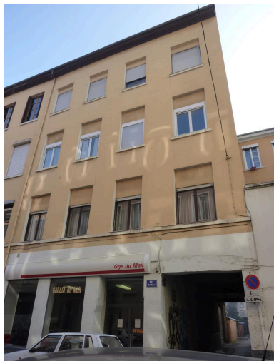
Vue d'ensemble de l'immeuble-atelier du 28 rue du mail Phot. Nadine Halitim-Dubois IVR84_20186901256NUCA
