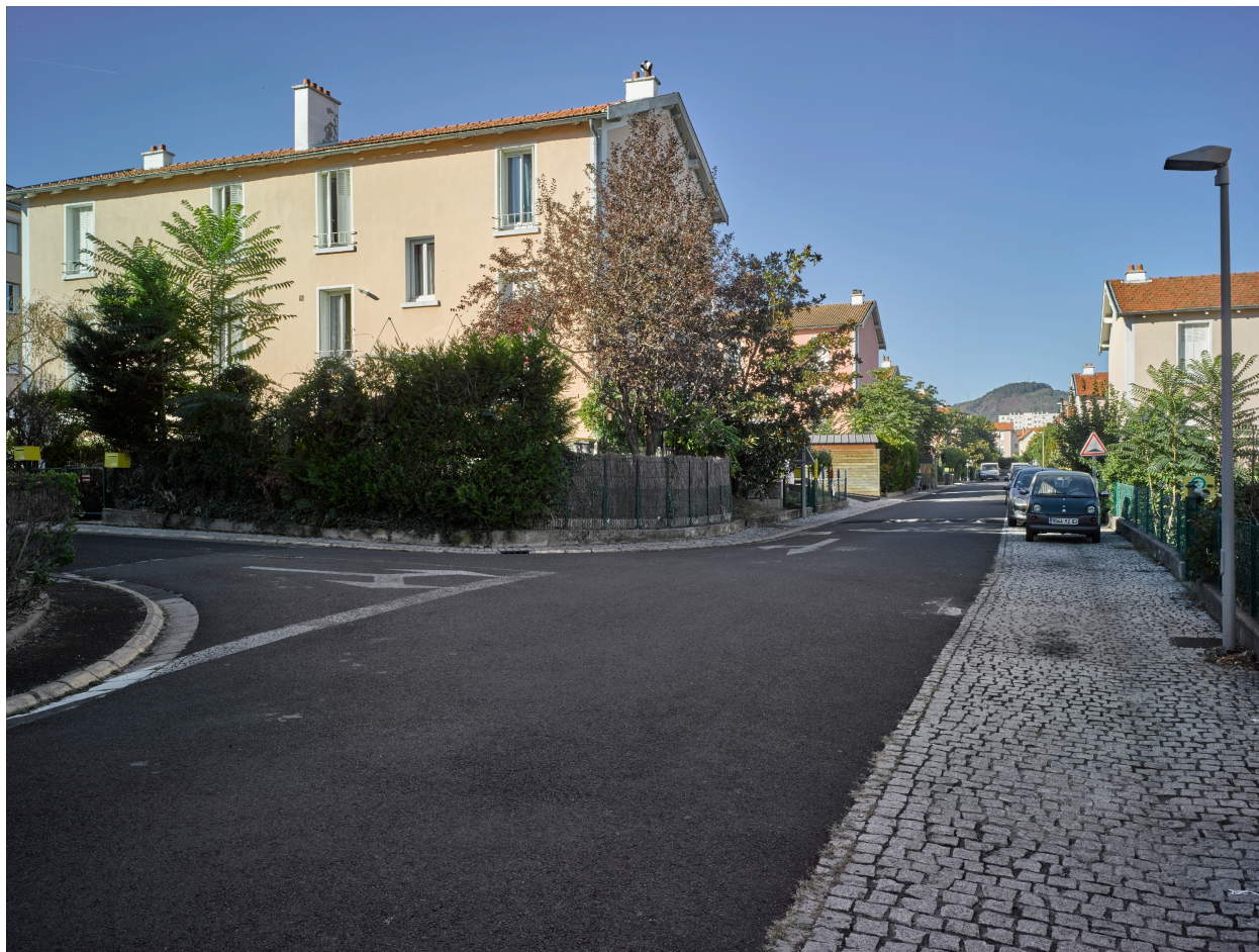
Habitations Michelin de type O (années 1920-1921) dans l'allée Sud, en direction de l'ouest.
