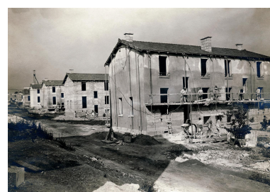
Chantier de la cité en août 1920.
