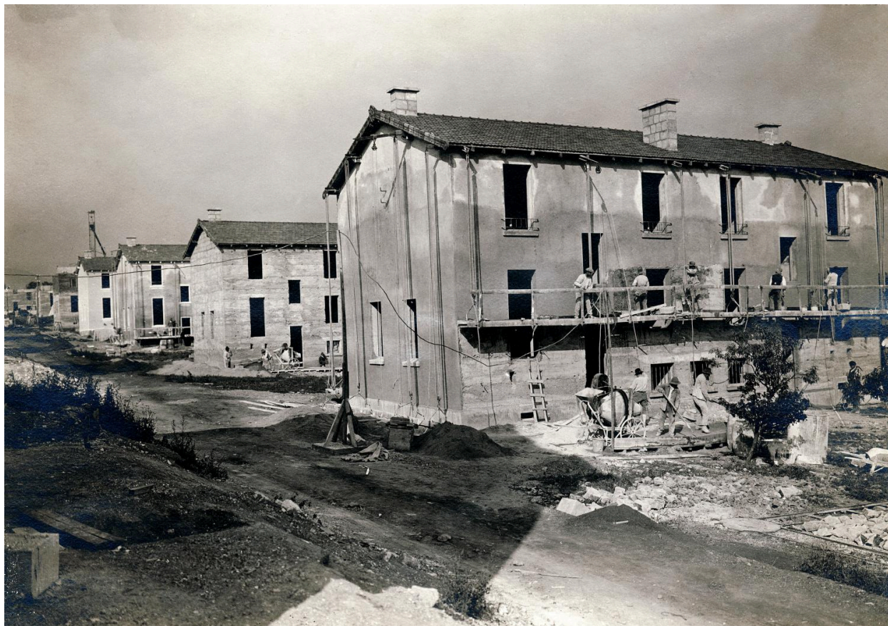
Chantier de la cité en août 1920.
