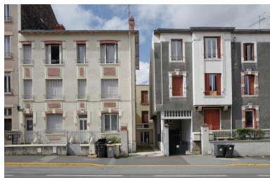
Allée de desserte de fond de parcelle entre les n°6 et 8 boulevard Fleury Phot. François-Nicolas L'Hardy IVR84_20246300368NUCA
