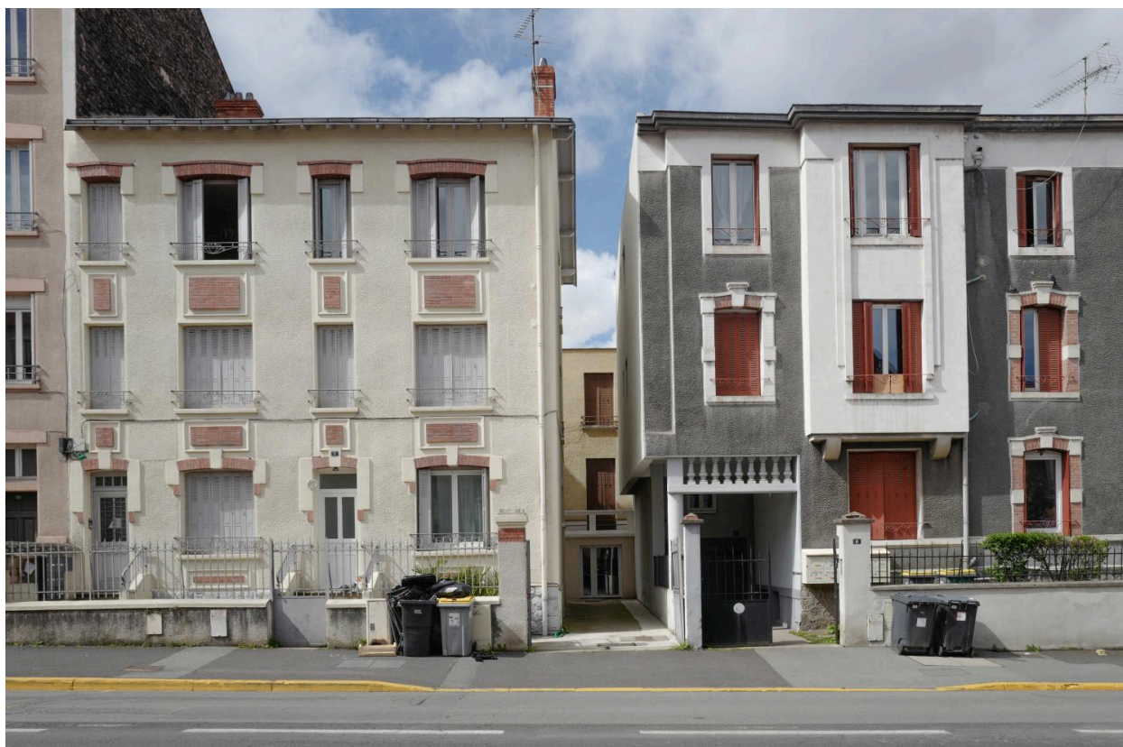
Allée de desserte de fond de parcelle entre les n°6 et 8 boulevard Fleury
