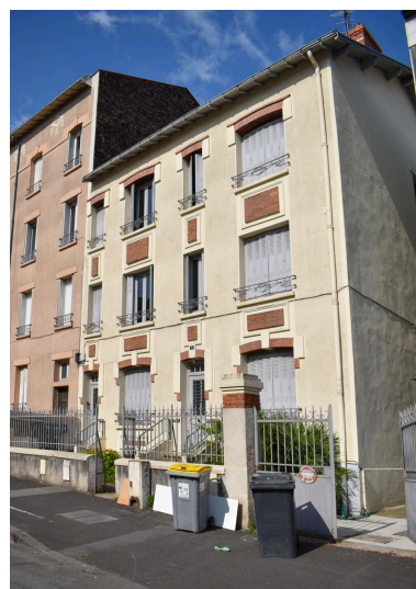
Façade sur le boulevard Fleury Phot. Félicie Fougère IVR84_20246300919NUCA
