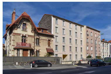
Elévation sur le boulevard Fleury Phot. Félicie Fougère IVR84_20246300909NUCA
