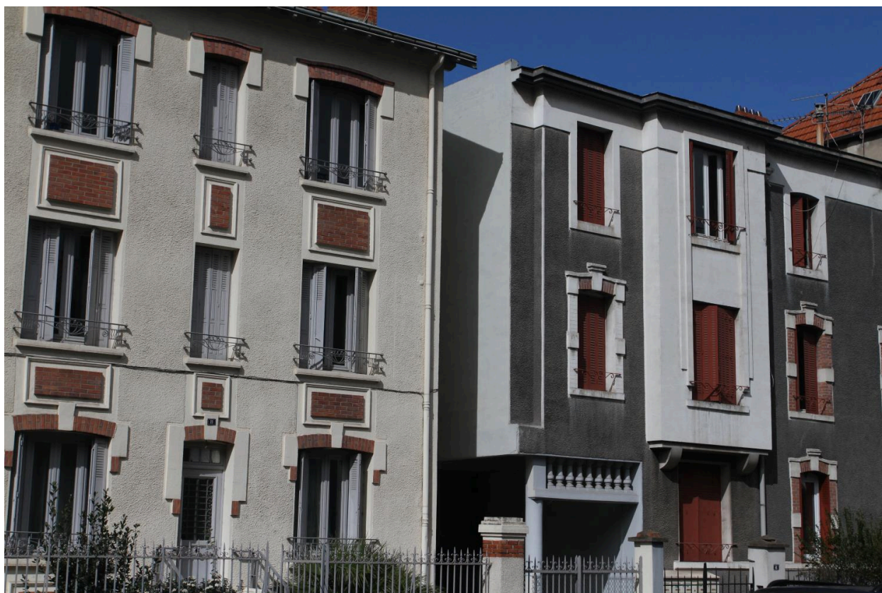
Détails des façades sur le boulevard
