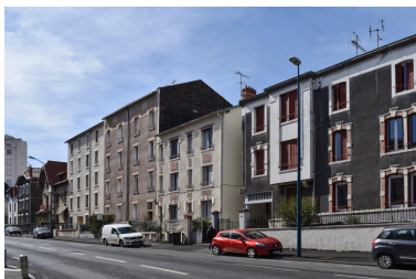
Façades sur le boulevard Fleury Phot. Félicie Fougère IVR84_20246300911NUCA
