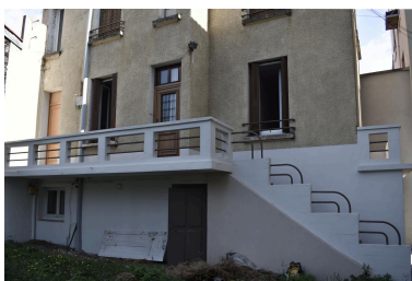
Façade sur le boulevard Fleury Phot. Félicie Fougère IVR84_20246300921NUCA
