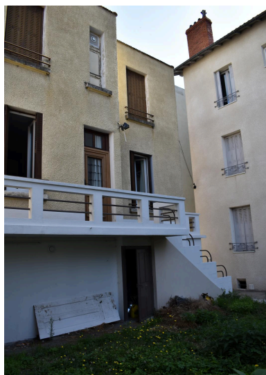
Elévation de l'immeuble en fond de parcelle Phot. Félicie Fougère IVR84_20246300923NUCA
