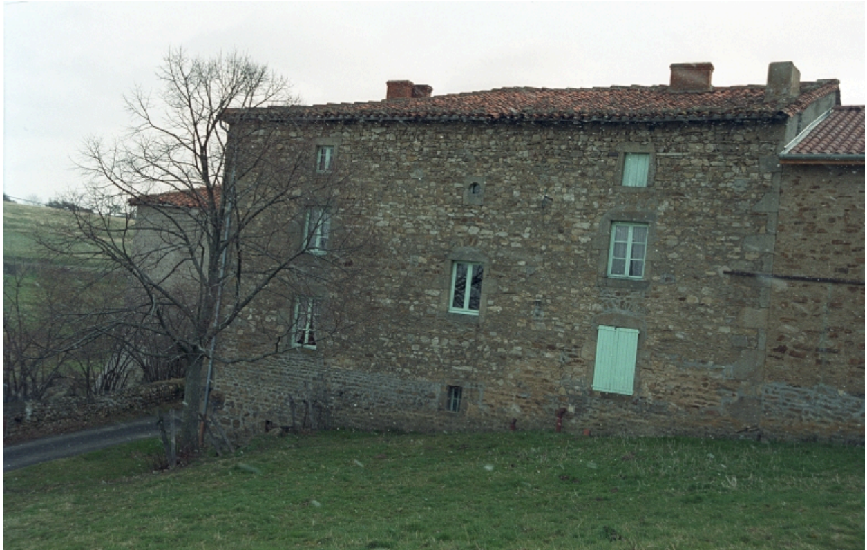
Vue de l'élévation postérieure du logis.
