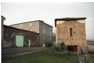
Vue d'ensemble du logis et de la chapelle, depuis le sud-est (mars 2001). Phot. Thierry Monnet IVR82_20034201505ZE
