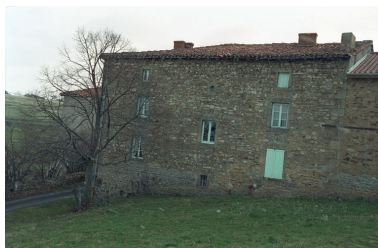
Vue de l'élévation postérieure du logis. Phot. Thierry Monnet IVR82_20034201508ZE
