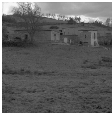
Vue d'ensemble depuis le sud-est. Phot. Eric Dessert IVR82_20034201496X
