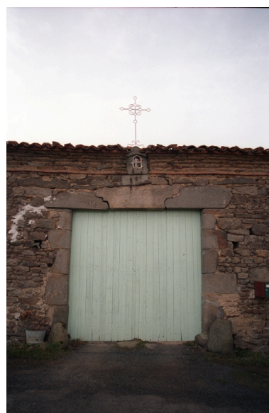
Vue d'ensemble du portail. Phot. Thierry Monnet IVR82_20034201506ZE
