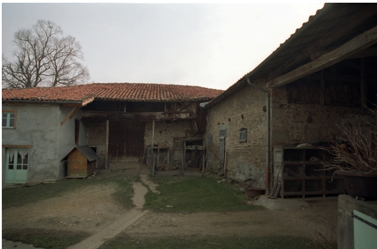
Vue de la cour, depuis le nord-ouest.
