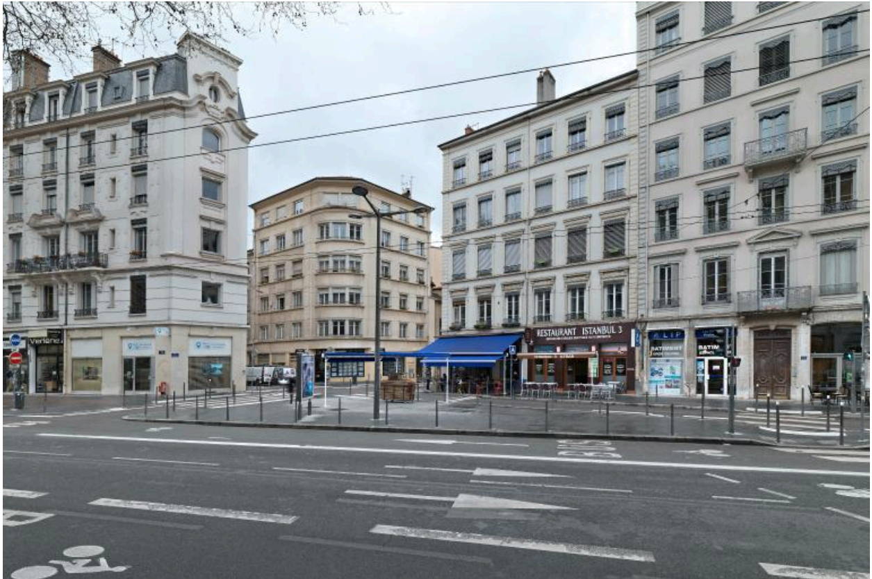
Vue de situation, depuis l'avenue Jean-Jaurès
