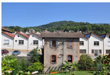
Vue du bâtiment des turbines transformé en local pour la coopérative d'entreprise actuellement sans affectation Phot. Yannick Milleret IVR82_20107300201NUCA
