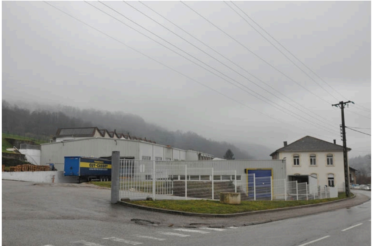
Vue nord du site de production avec le bâtiment administratif et les locaux d'expédition
