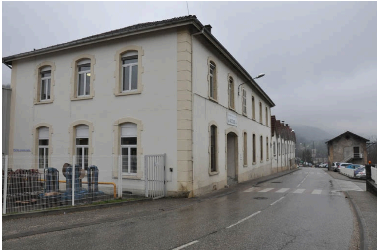
Vue de l'usine le long de la route départementale D 921 E
