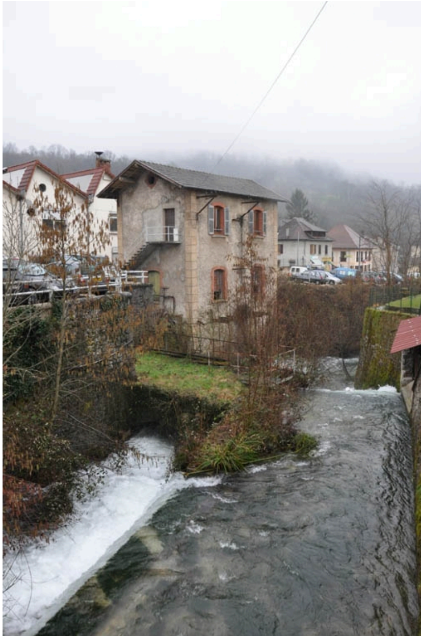
Vue du bâtiment des turbines avec la prise d'eau sur le ruisseau du Tier
