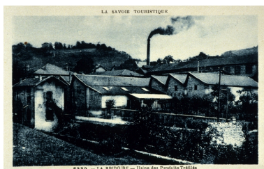
Vue générale avec sur la gauche l'usine génératrice d'électricité, début du 20e siècle Phot. Repro. Musées d'Art et d'Histoire de Chambéry IVR82_20107303025NUCA
