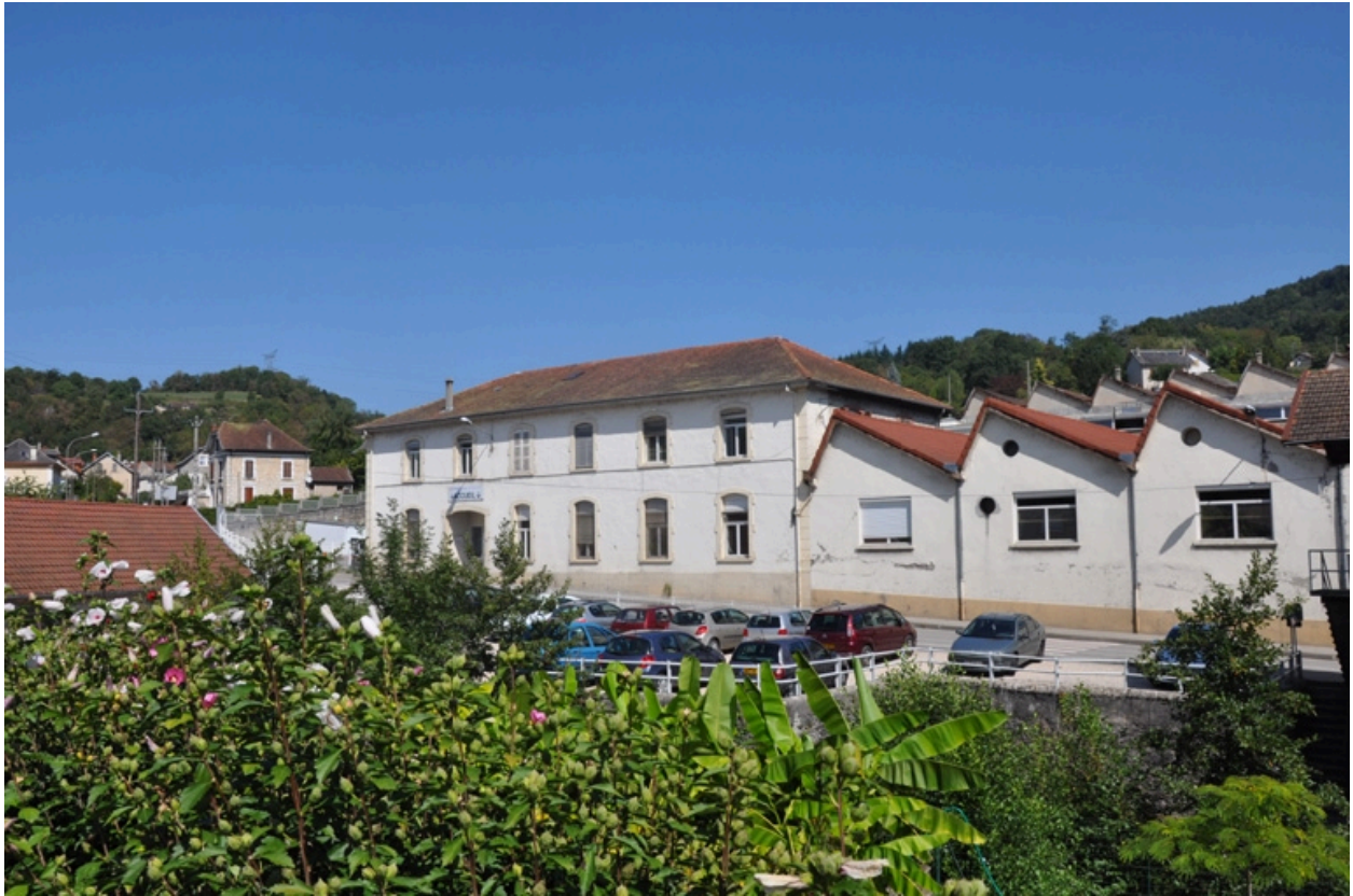
Vue façade ouest avec le bâtiment administratif
