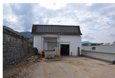
Vue de l'entrée du bâtiment du tissage métallique, façade nord Phot. Yannick Milleret IVR82_20107300204NUCA
