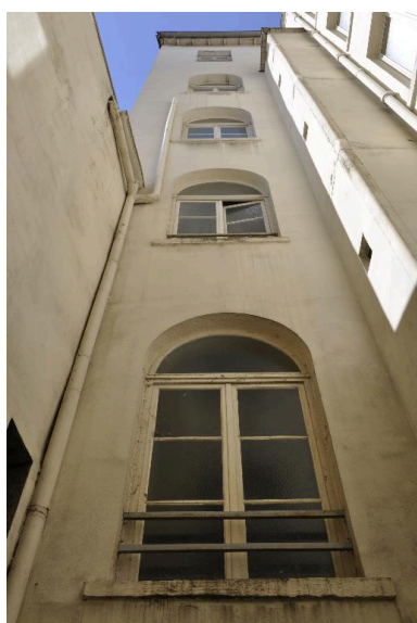
Vue partielle de l'élévation sur cour (cage d'escalier) Phot. Catherine Guégan IVR84_20166900766NUCA
