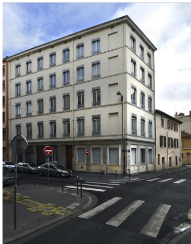
Vue d'ensemble depuis le sud-ouest Phot. Franck Trabouillet IVR84_20186901161NUCAQ
