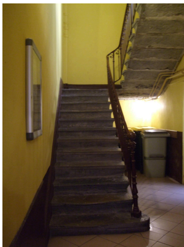
Escalier à vide central rampe sur rampe Phot. Nadine Halitim-Dubois IVR84_20186901275NUCA
