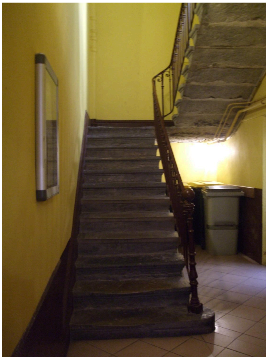
Escalier à vide central rampe sur rampe
