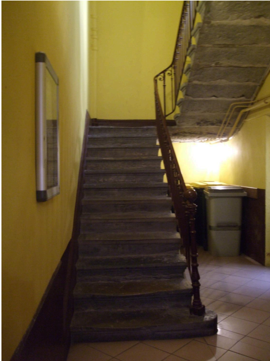
Escalier à vide central rampe sur rampe
