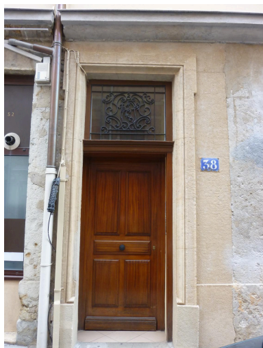
Porte piétonne Phot. Nadine Halitim-Dubois IVR84_20186901277NUCA
