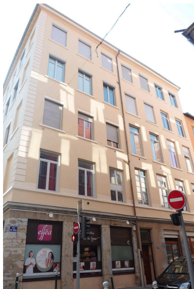
Façade principale rue Pailleron Phot. Nadine Halitim-Dubois IVR84_20186901274NUCA
