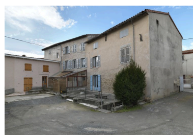
Vue d'ensemble des élévations arrière sur cour. Phot. Thierry_Leroy IVR82_20144200079NUCAQ
