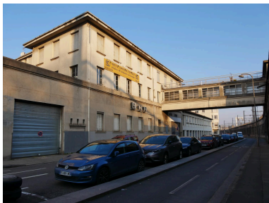
Détail passerelle et bâtiment rue Raoul Servant (vue sud-ouest) Phot. Nadine Halitim-Dubois IVR84_20226901515NUCA
