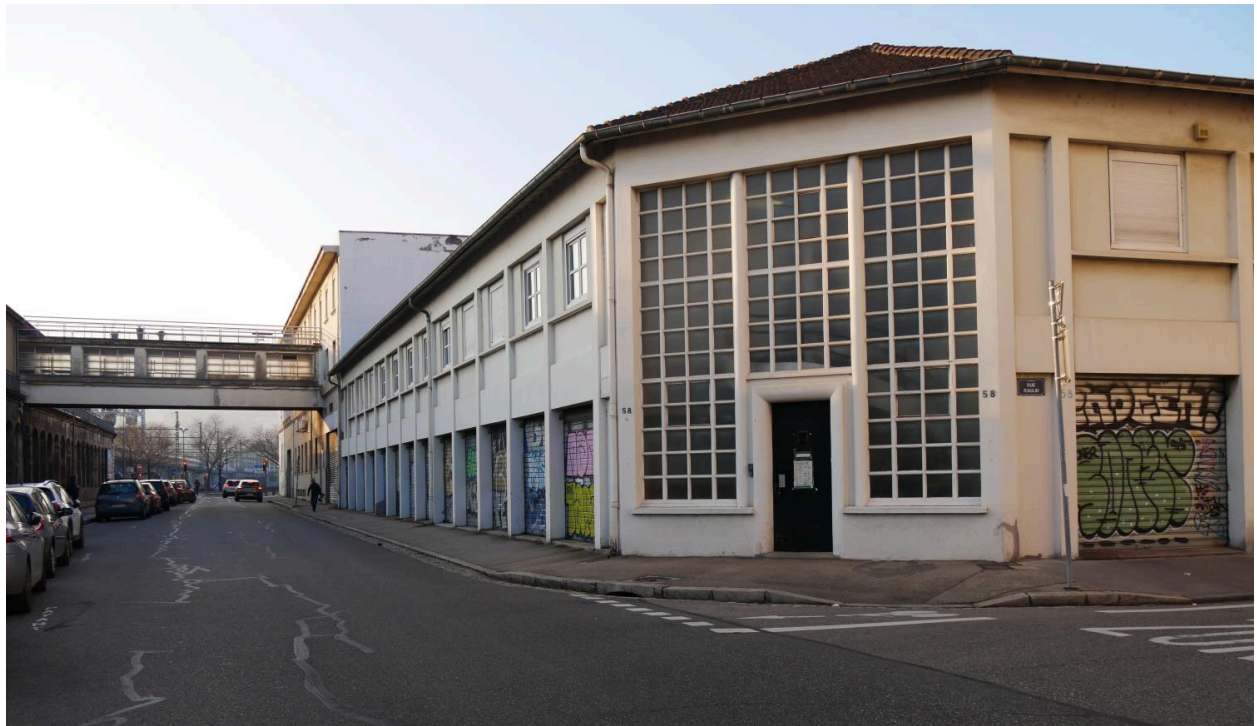
Vue d'ensemble nord-est
