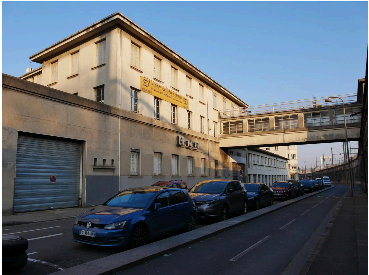
Détail passerelle et bâtiment rue Raoul Servant (vue sud-ouest)
