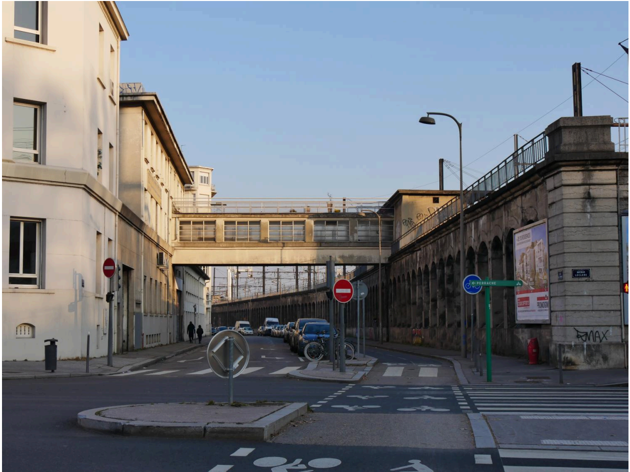
Vue de la passerelle reliant les voies ferrées rue Raoul Servant
