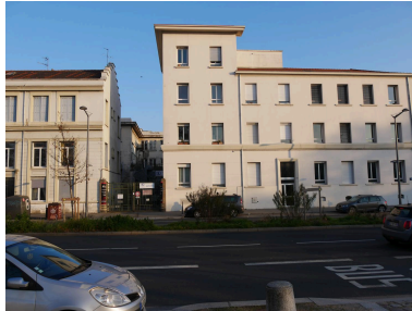
Vue de la façade principale Phot. Nadine Halitim-Dubois IVR84_20226901513NUCA
