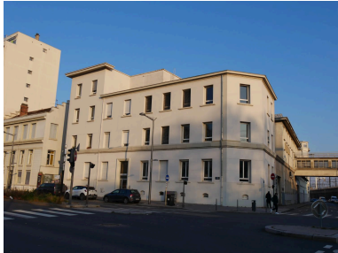
Vue d'ensemble Est du site Phot. Nadine Halitim-Dubois IVR84_20226901512NUCA
