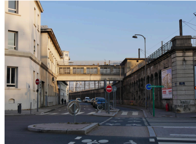
Vue de la passerelle reliant les voies ferrées rue Raoul Servant Phot. Nadine Halitim-Dubois IVR84_20226901514NUCA
