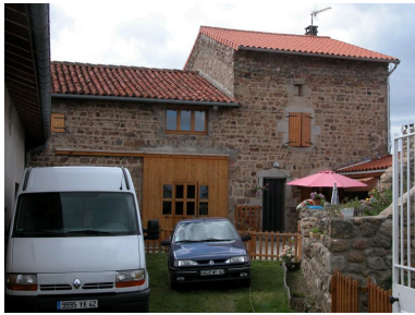
Vue générale Phot. Thierry Monnet IVR82_20124200795NUCA
