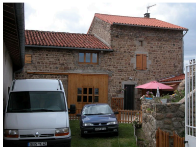
Vue générale Phot. Thierry Monnet IVR82_20124200795NUCA
