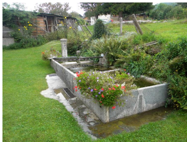
Vue de trois-quarts Phot. Jérôme Daviet IVR82_20157401702NUCA
