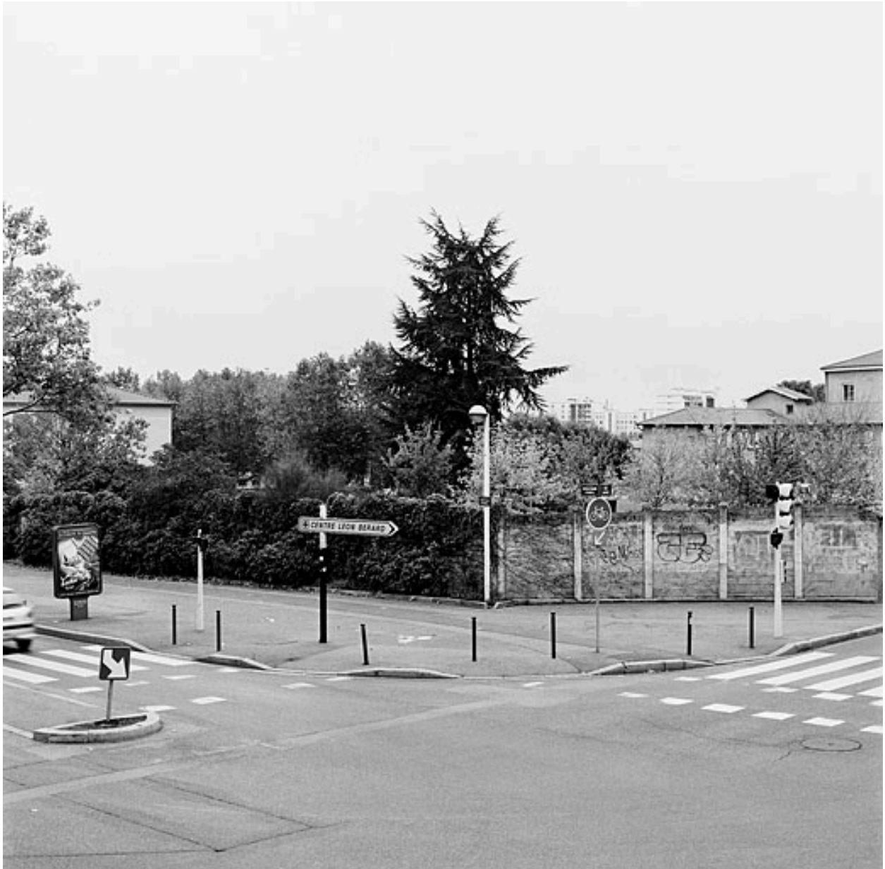
Vue façade sud-est
