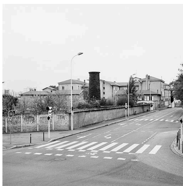
Vue d'ensemble nord-est Phot. Didier Gourbin IVR82_20046902963X
