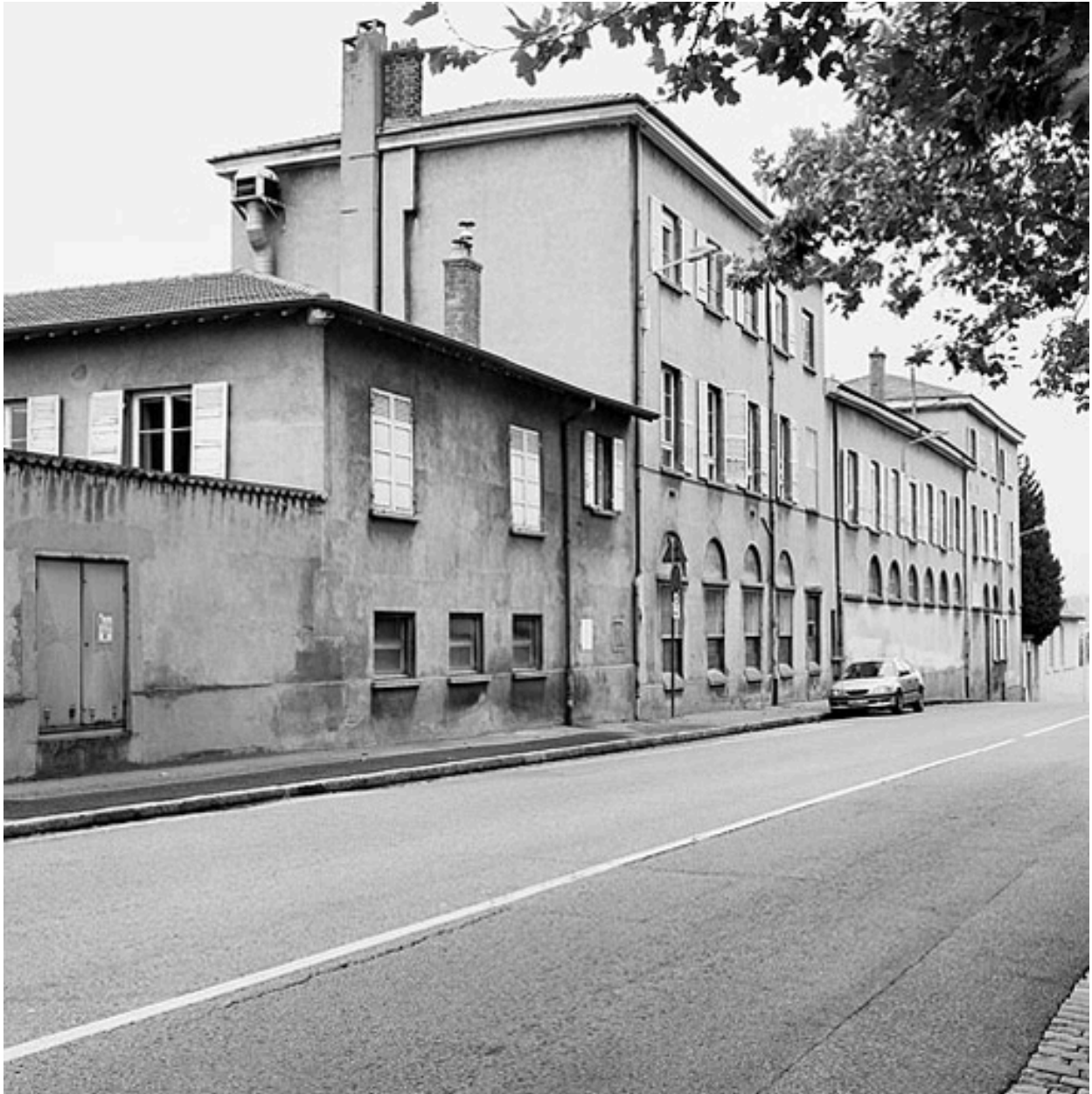
Vue façade nord en alignement de la rue Laënnec
