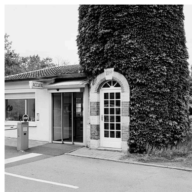
Cheminée ou éolienne avec date portée Phot. Didier Gourbin IVR82_20046902973X
