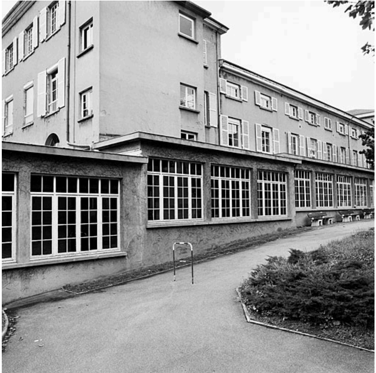
Vue d'ensemble sud des bâtiments
