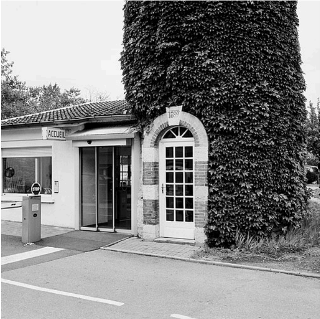
Cheminée ou éolienne avec date portée
