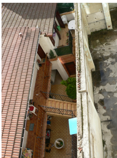
Façade arrière Phot. Isabelle Dupuis IVR82_20093800345NUCA
