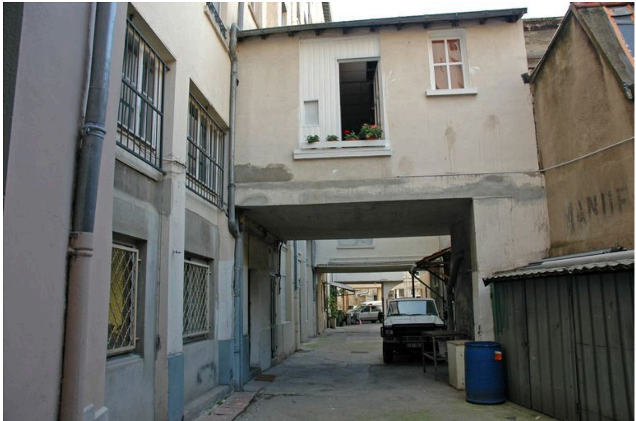
Loge de concierge. Vue depuis le nord
