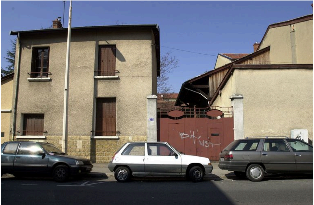
Vue générale des bâtiments sur rue
