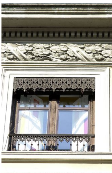
Façade principale, détail d'une fenêtre du dernier étage Phot. Lore Derail
