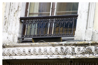
Façade principale, détail du cordon entre le rez-de- chaussée et le 1er étage Phot. Lore Derail IVR82_20046900069NUCA
