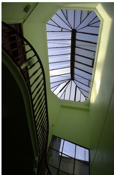
Escalier, vue intérieure de la couverture de la cage Phot. Lore Derail IVR82_20046900076NUCA
