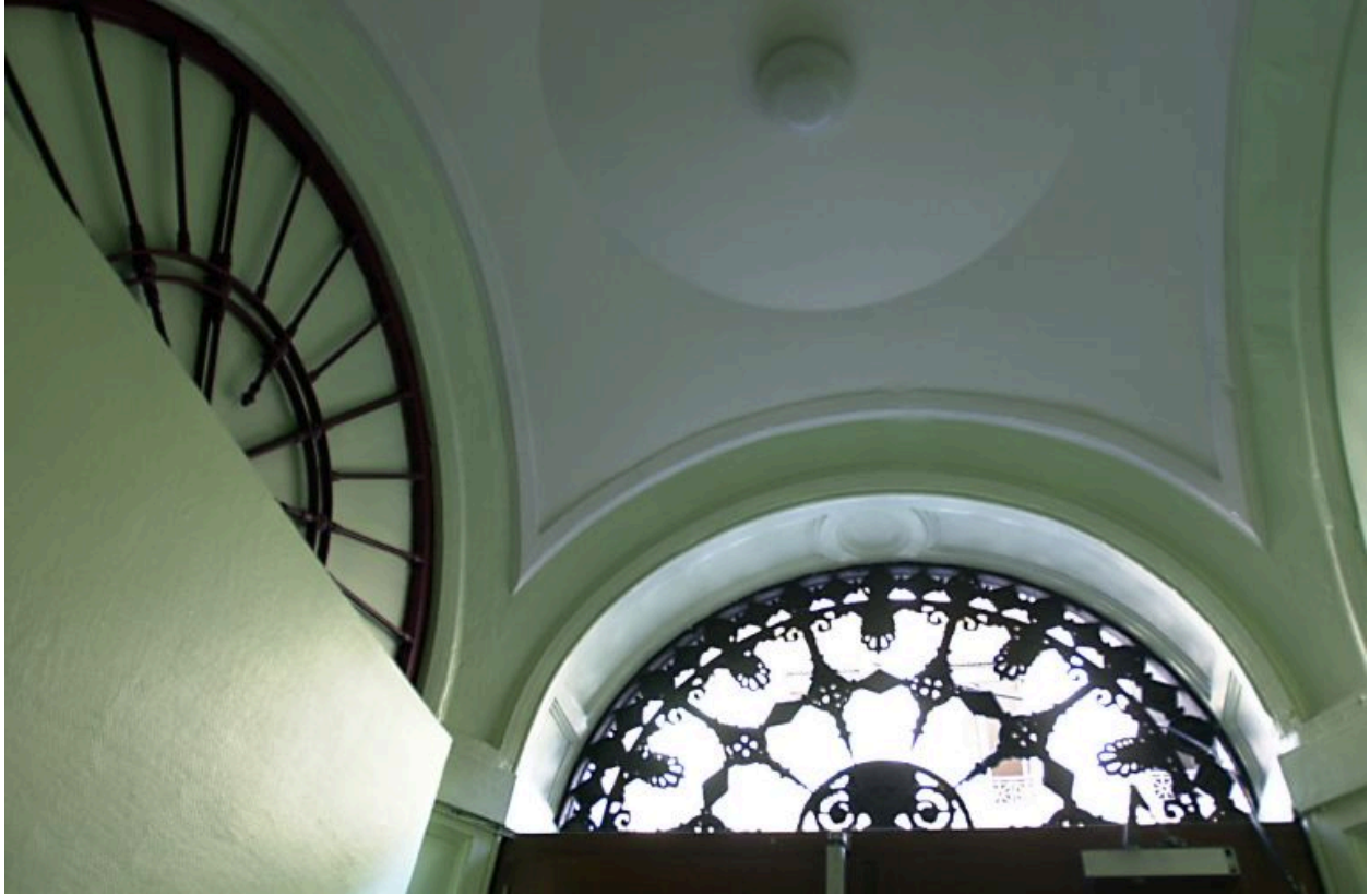
Coupole du sas d'entrée
