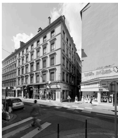
Vue générale des façades Phot. Didier Gourbin IVR82_20056902664V
