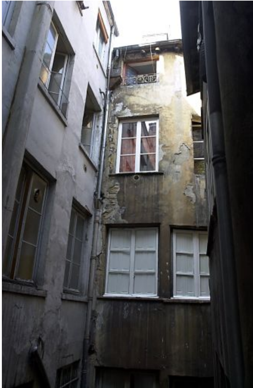
A gauche, façade sur cour de l'aile en retour, niveaux supérieurs
