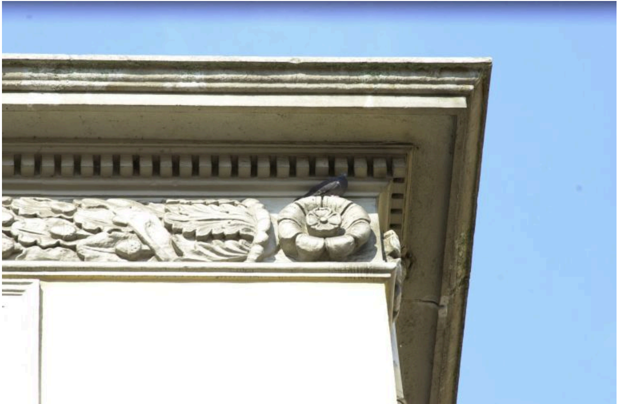
Façade principale, détail de la corniche
