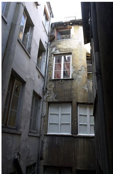
A gauche, façade sur cour de l'aile en retour, niveaux supérieurs Phot. Lore Derail IVR82_20046900074NUCA
