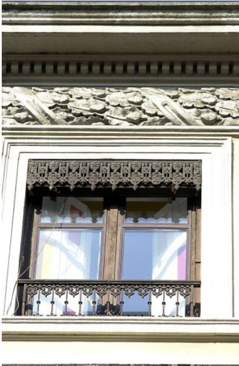
Façade principale, détail d'une fenêtre du dernier étage
