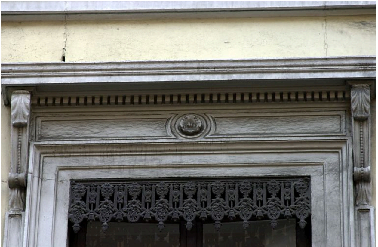
Façade principale, détail de la corniche d'une fenêtre du 2e étage
