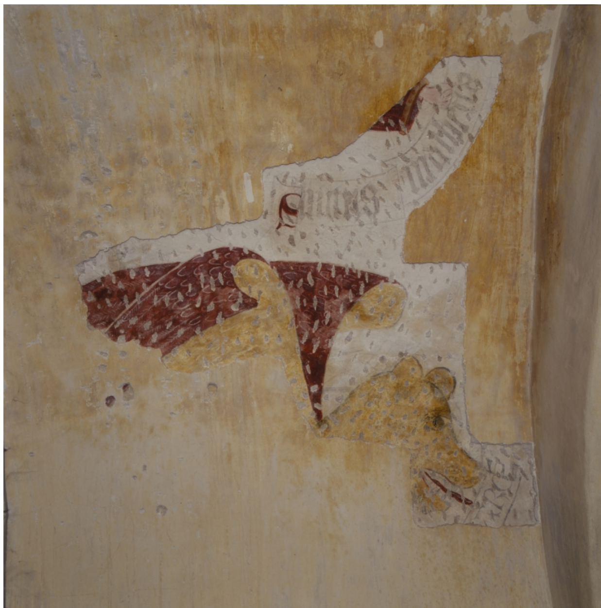
Voûte du chœur : lion de saint Marc.
