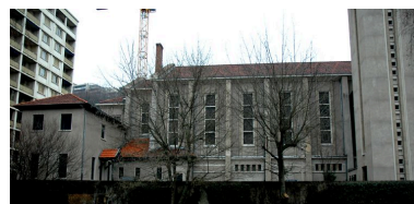
Façade ouest. Détail Phot. Maryannick Chalabi IVR82_20066901052NUCA
