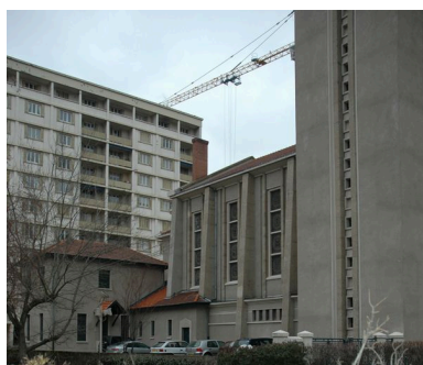
Vue depuis le sud-ouest. La chapelle Sainte-Monique Phot. Maryannick Chalabi IVR82_20066901050NUCA
