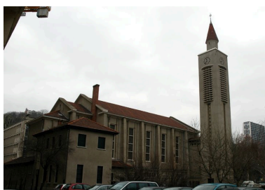
Vue d'ensemble depuis le nord-ouest Phot. Maryannick Chalabi IVR82_20066901053NUCA
