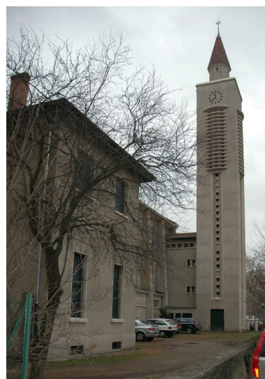
Vue depuis l'ouest Phot. Maryannick Chalabi IVR82_20066901054NUCA
