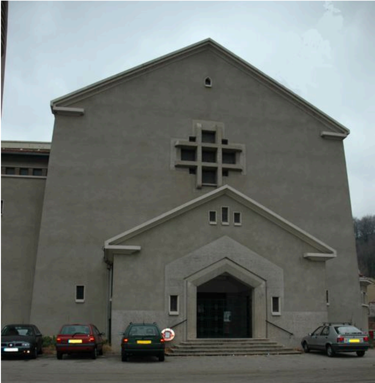
Facade principale depuis le sud-ouest
