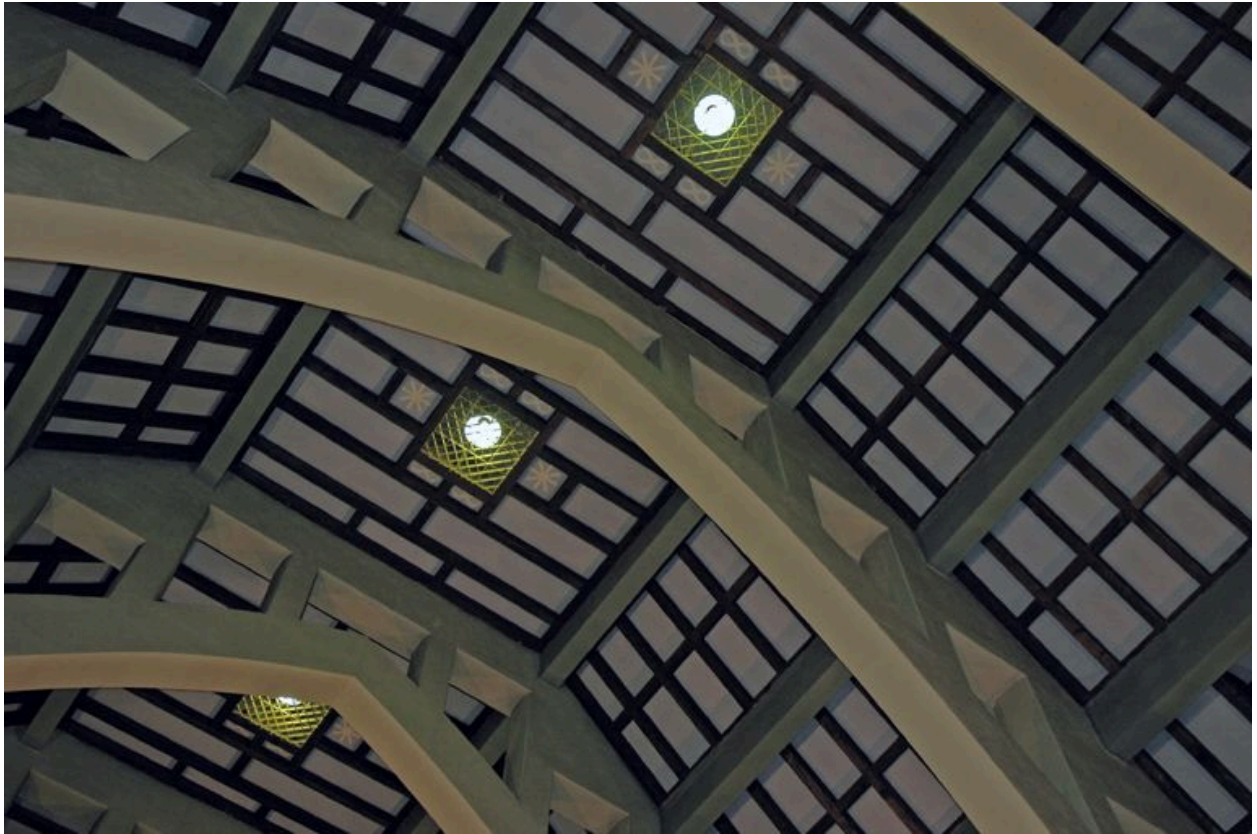
Le couvrement de la nef : les arcs diaphragme
