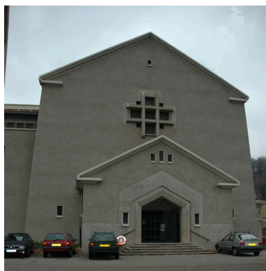
Façade principale depuis le sud-ouest Phot. Maryannick Chalabi IVR82_20066901049NUCA
