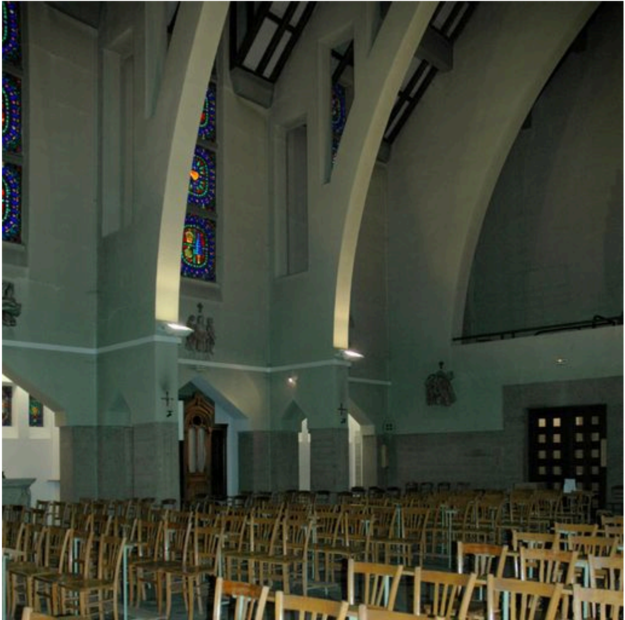
Vue de la nef depuis le nord ouest
