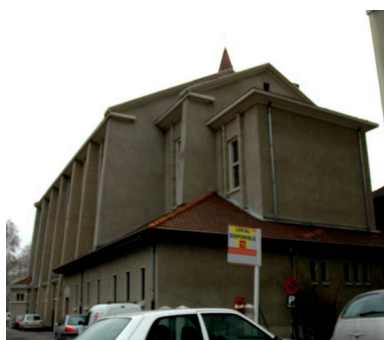
Vue d'ensemble depuis le nord-est Phot. Maryannick Chalabi IVR82_20066901055NUCA
