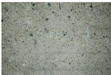
Détail du matériau du gros-œuvre Phot. Maryannick Chalabi IVR82_20066901016NUCA
