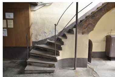
Vue du départ de l'escalier Phot. Nadine Halitim-Dubois IVR82_20146900317NUCA
