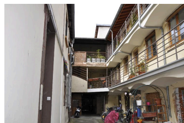
Vue est depuis la cour Phot. Nadine Halitim-Dubois IVR82_20146900316NUCA
