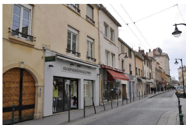
Vue d'ensemble nord ouest de l'immeuble de deux étages Phot. Nadine Halitim-Dubois IVR82_20146900312NUCA
