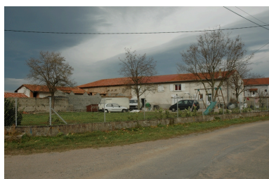
Vue générale depuis le sud-est. Phot. Caroline Guibaud IVR82_20114200579NUCA
