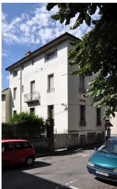
Vue depuis l'arrière Phot. François Fouger IVR82_20117300573NUCA
