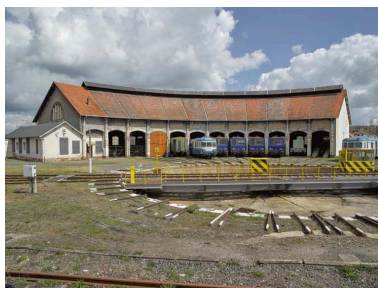
Demi-rotonde ferroviaire avec pont tournant de la gare de Montluçon, de face.
