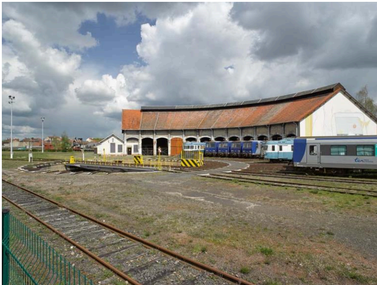
Demi-rotonde ferroviaire avec pont tournant de la gare de Montluçon.
