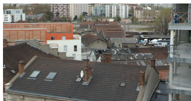
Vue générale, série de 5 ateliers accolés avec toits à longs pans Phot. Nadine Halitim-Dubois IVR82_20086900277NUCA
