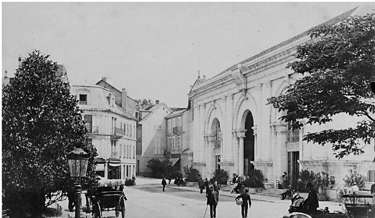
Vue générale depuis la place des Bains, vers 1880
