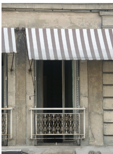
Détail d'un garde-corps Phot. François Fouger IVR82_20037300026NUCA
