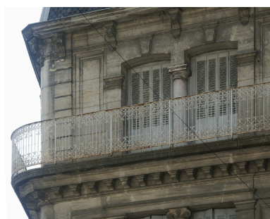
Détail de l'angle des façades Phot. François Fouger IVR82_20037300027NUCA
