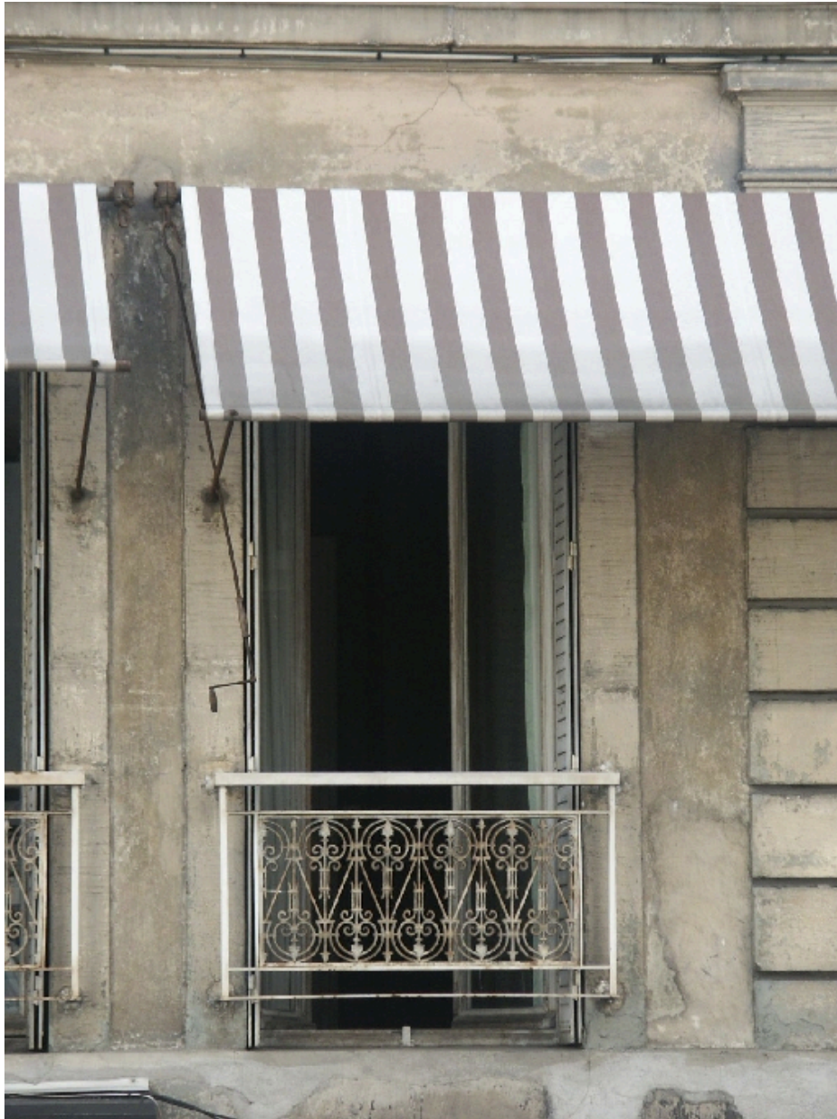
Détail d'un garde-corps
