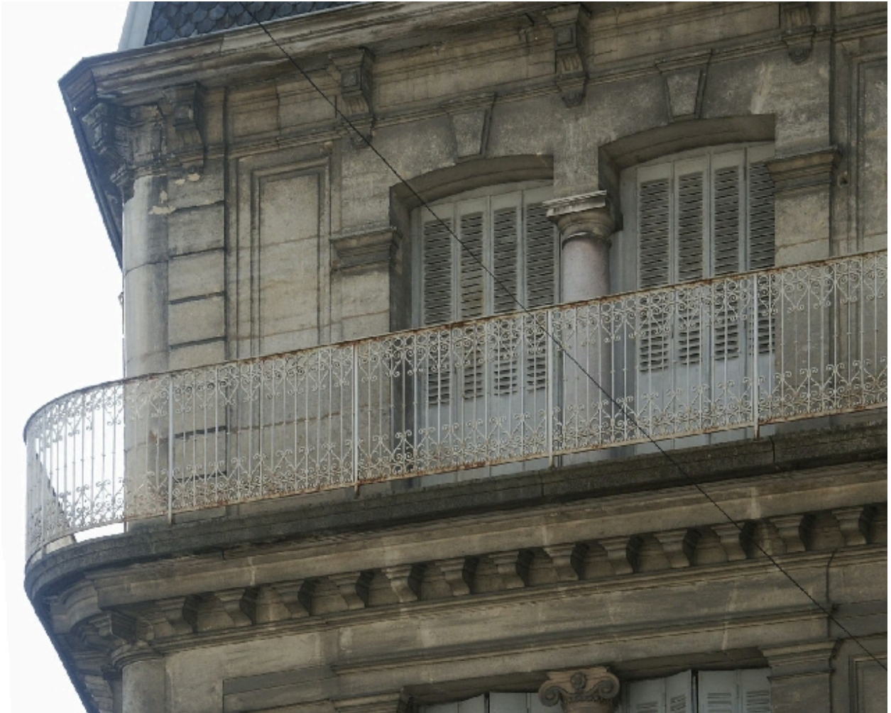
Détail de l'angle des façades
