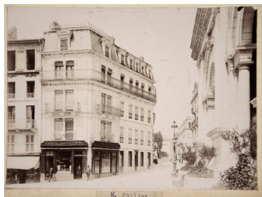
Immeuble Folliet, après surélévation, vers 1898 Repro. François Fouger IVR82_20127300708NUCB
