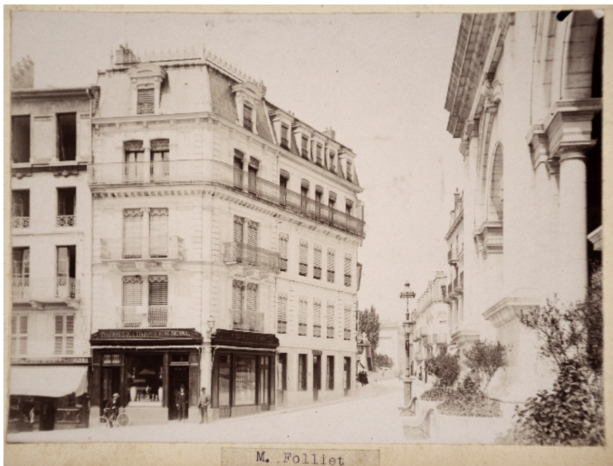
Immeuble Folliet, après surélévation, vers 1898
