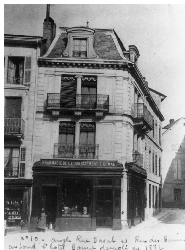
Pharmacie Pichon : façade sur la rue des Bains, avant surélévation Repr. François Fouger IVR82_20047300006NUCB
