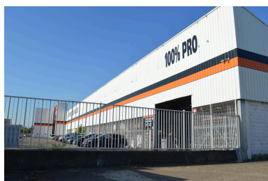
La Plateforme du bâtiment - vue depuis l'avenue Francis de Pressensé - mai 2022 Phot. Alice Giacobelli IVR84_20226900979NUCA
