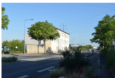
Prolians - bâtiment situé à l'angle de l'avenue Francis de Pressensé et le Chemin de Tâche-Velin - mai 2022 Phot. Alice Giacobelli IVR84_20226900936NUCA
