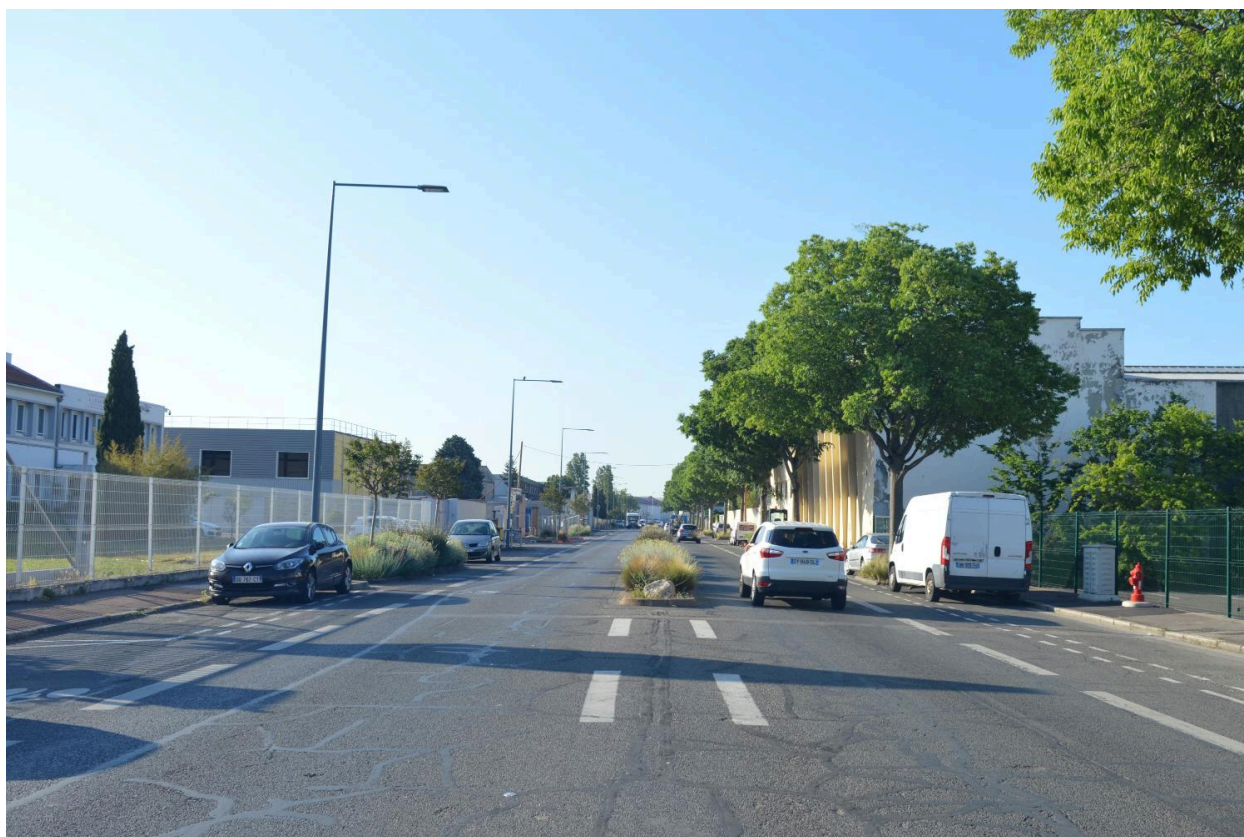
Profil de l'avenue Francis de Pressensé avec à droite les entreprises Munoz et Prolians et à gauche Aldes Aéraulique - mai 2022
