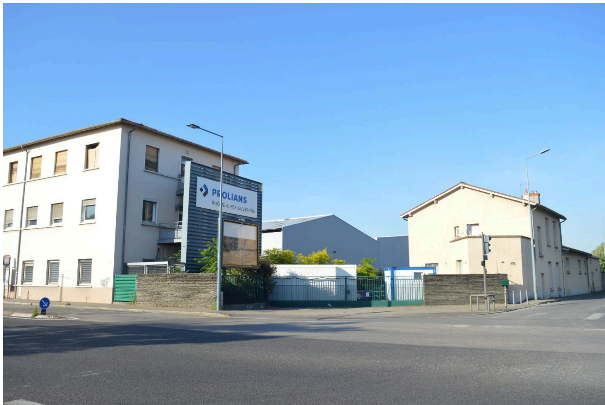
Prolians - bâtiments situés à l'angle de l'avenue Francis de Pressensé et le Chemin de Tâche-Velin - mai 2022
