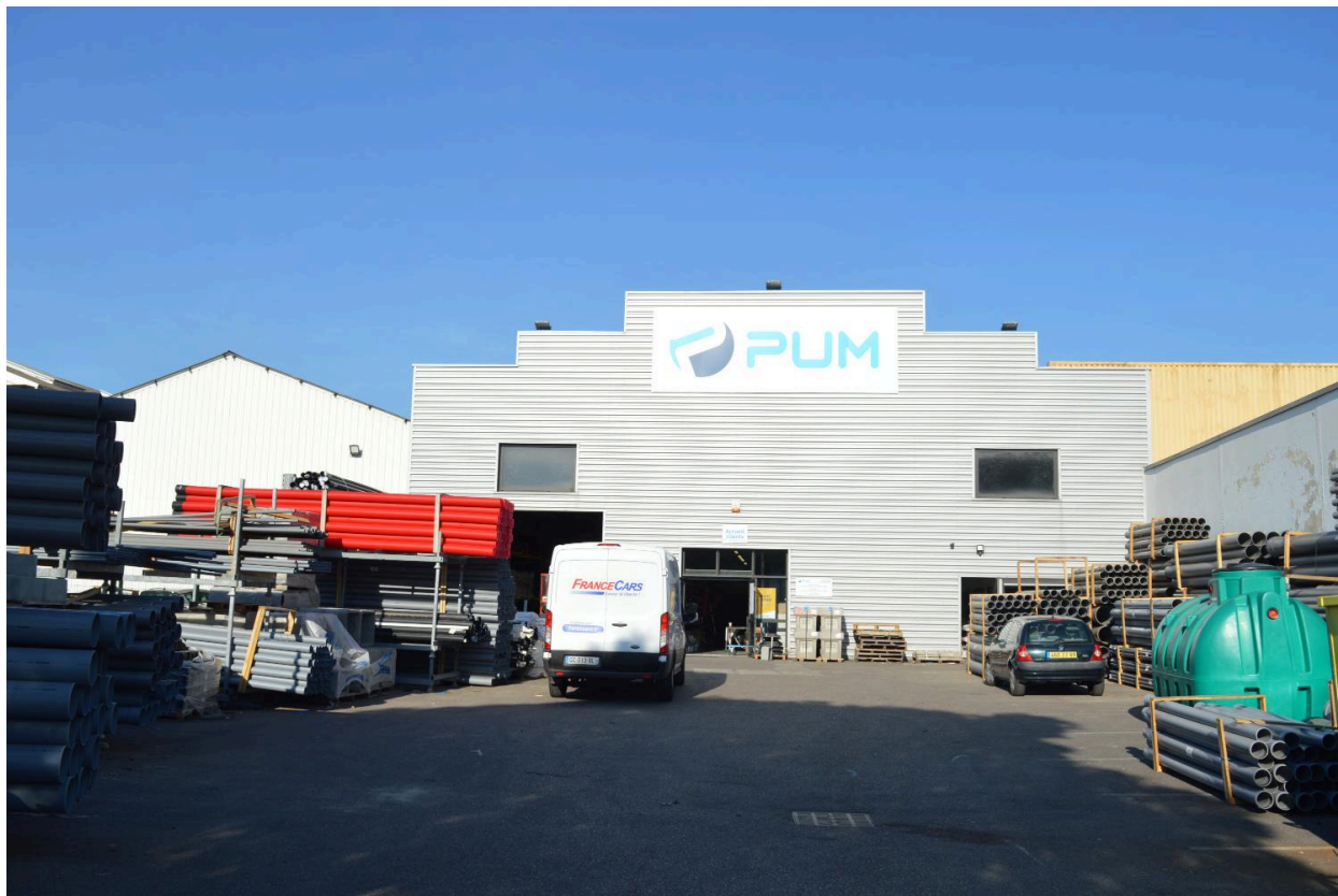
Entreprise PUM - vue depuis l'avenue Francis de Pressensé - mai 2022
