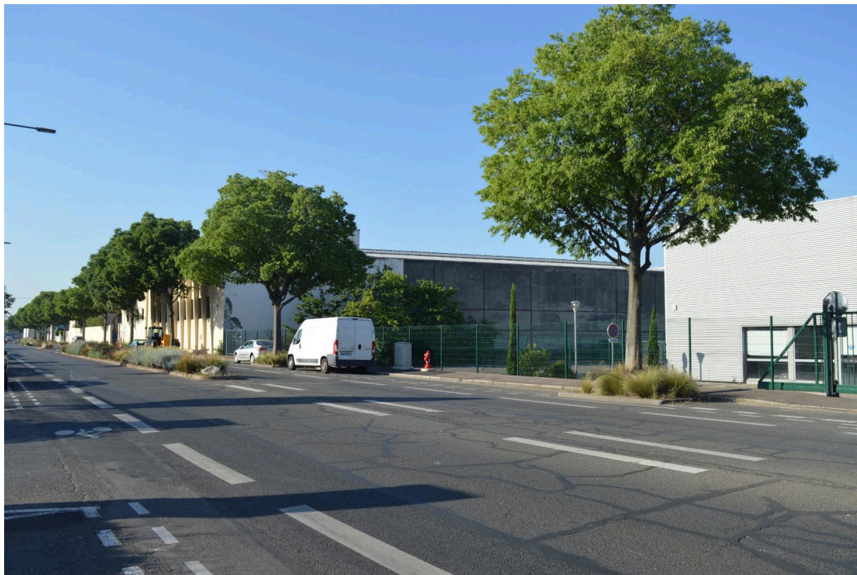
Entreprise Munoz - vue depuis l'avenue Francis de Pressensé - mai 2022
