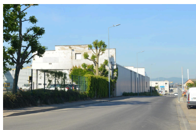
Prolians - bâtiment situé le long du Chemin de Tâche-Velin - mai 2022 Phot. Alice Giacovelli IVR84_20226900945NUCA
