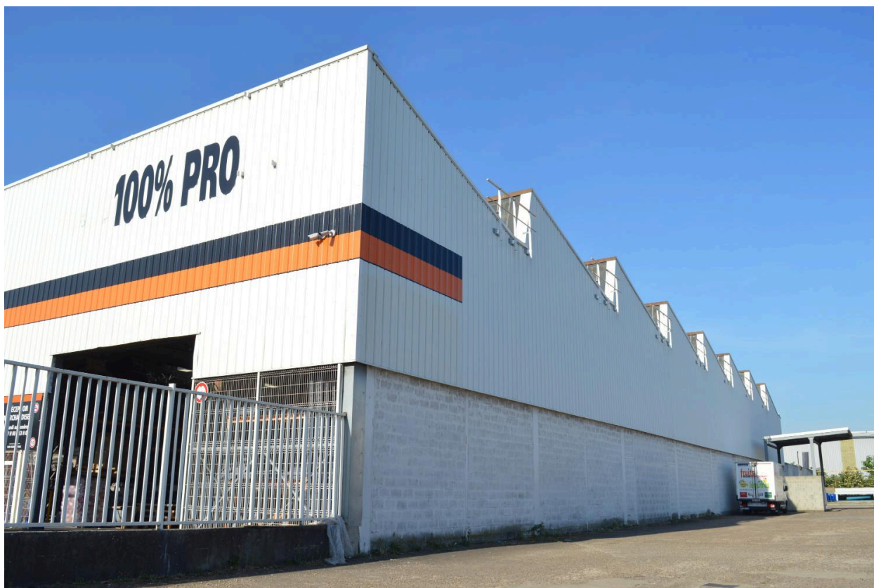
La Plateforme du bâtiment - vue depuis l'avenue Francis de Pressensé - mai 2022
