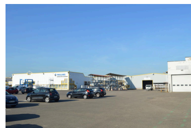
Site de l'entreprise Prolians - vue du Chemin de Tâche-Velin - mai 2022 Phot. Alice Giacovelli IVR84_20226900953NUCA
