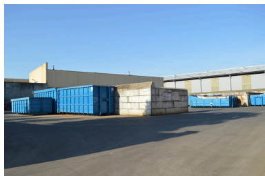
Entreprise Munoz - grandes halles vues depuis l'avenue Francis de Pressensé - mai 2022 Phot. Alice Giacobelli IVR84_20226900932NUCA
