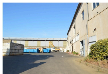
Entreprise Munoz - grandes halles vues depuis l'avenue Francis de Pressensé - mai 2022 Phot. Alice Giacobelli IVR84_20226900931NUCA
