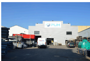
Entreprise PUM - vue depuis l'avenue Francis de Pressensé - mai 2022 Phot. Alice Giacobelli IVR84_20226900978NUCA
