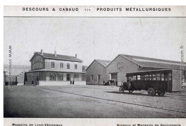
Descours et Cabaud - Produits métallurgiques - Magasins de Lyon-Vénissieux - Bureaux et magasins de boulonnerie (Association Viniciacum) Phot. Alice Giacovelli IVR84_20226900403NUC
