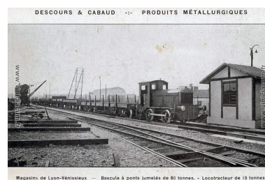
Descours et Cabaud - Produits métallurgiques - Magasins de Lyon-Vénissieux - Bascule à ponts jumelés de 80 tonnes - Locotracteur de 15 tonnes (Association Viniciacum) Phot. Alice Giacovelli IVR84_20226900404NUC
