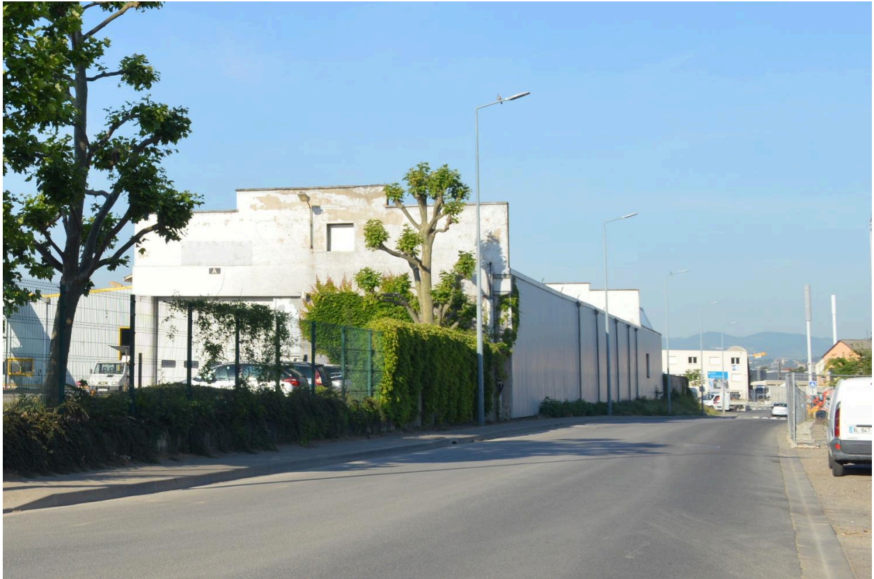
Prolians - bâtiment situé le long du Chemin de Tâche-Velin - mai 2022
