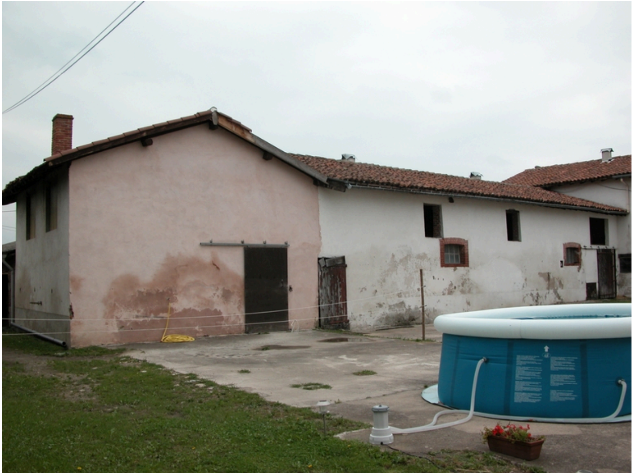
Vue de l'étable et fenil ouest de la première cour.
