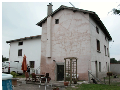
Vue de l'habitation de la première cour, depuis le sud-est. Phot. Thierry Monnet IVR82_20134204656NUCA
