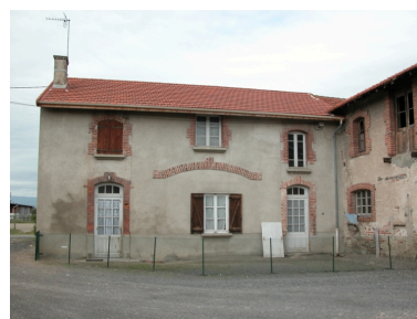
Vue des bâtiments ouest de la deuxième cour, depuis l'est : habitation, étable et logement (?). Phot. Thierry Monnet IVR82_20134204675NUCA
