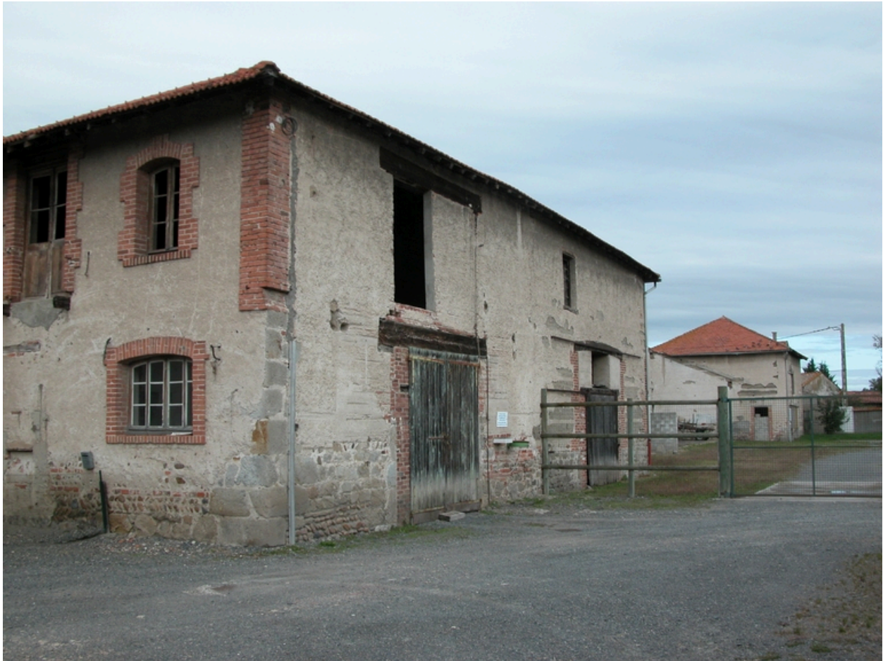
Vue des bâtiments ouest de la deuxième cour, depuis le sud-est : étable et logement (?), habitation de la troisième cour en arrière-plan.
