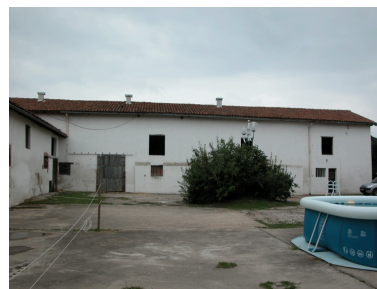
Vue de l'étable et fenil nord de la première cour. Phot. Thierry Monnet IVR82_20134204655NUCA
