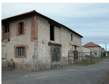
Vue des bâtiments ouest de la deuxième cour, depuis le sud-est : étable et logement (?), habitation de la troisième cour en arrière-plan.
