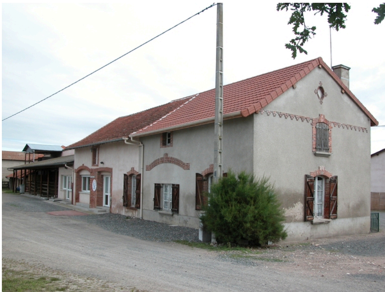
Vue des bâtiments ouest de la deuxième cour, depuis le sud-ouest : habitation, partie transformée en laboratoire.
