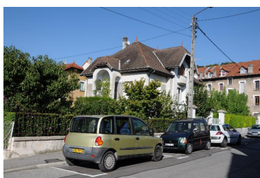
Vue d'ensemble Phot. Denys Harreau IVR82_20137301138NUCA
