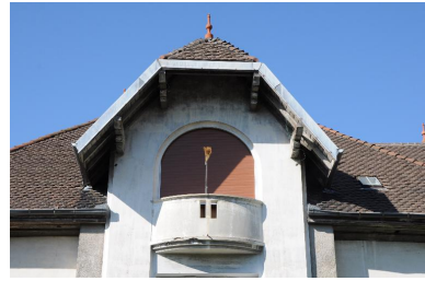
Lucarne-pignon sur la façade principale Phot. Denys Harreau IVR82_20137301136NUCA
