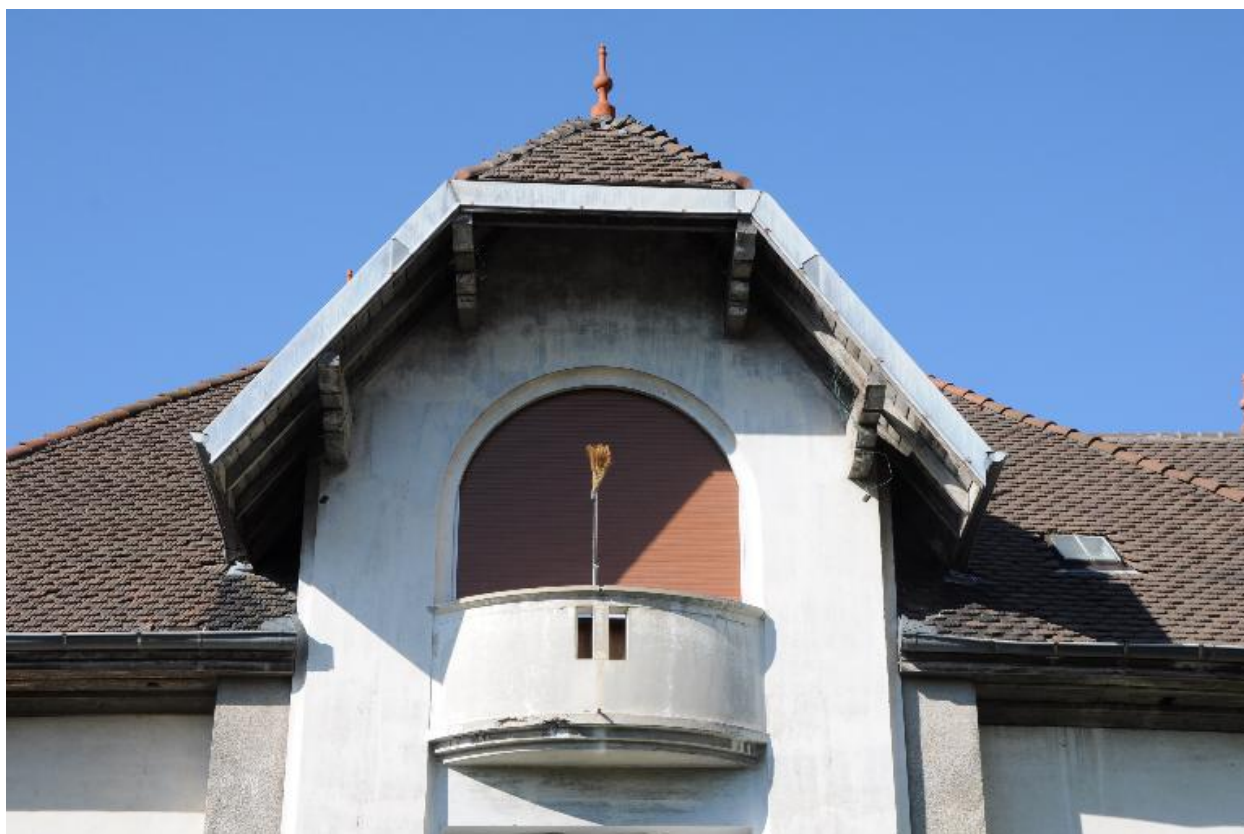
Lucarne-pignon sur la façade principale
