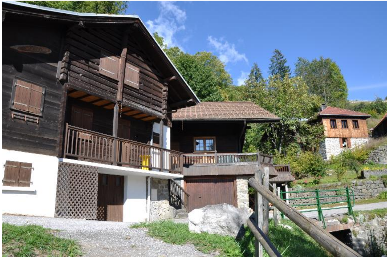
Vue de la façade postérieure ouest du bâtiment de l'ancienne forge
