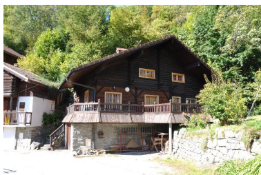
Vue de la façade antérieure de l'ancienne forge de Manigod Phot. Samir Mahfoudi IVR84_20167400027NUCA
