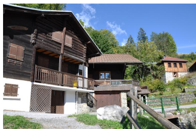
Vue de la façade postérieure ouest du bâtiment de l'ancienne forge Phot. Samir Mahfoudi IVR84_20167400026NUCA
