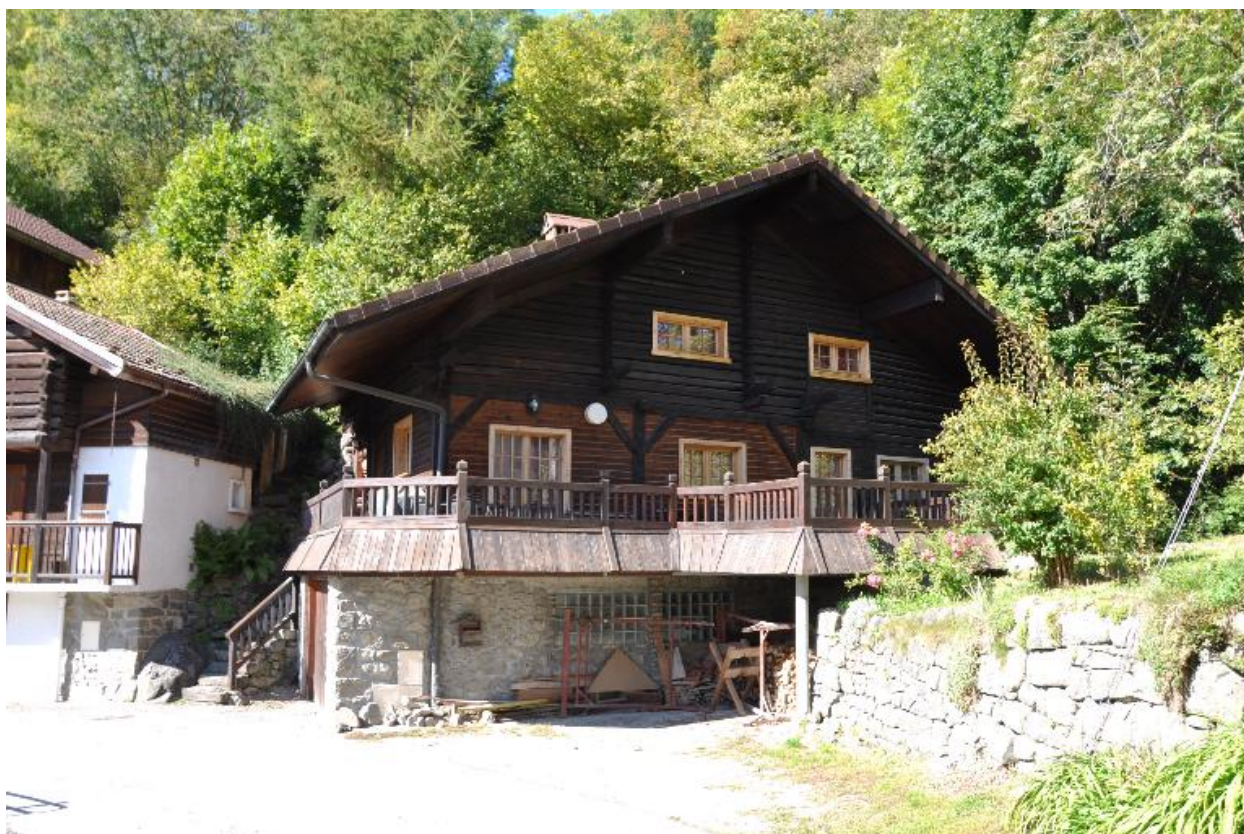
Vue de la façade antérieure de l'ancienne forge de Manigod
