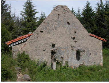
Vue d'ensemble depuis le sud-ouest. Phot. Caroline Guibaud IVR82_20124201475NUCA
