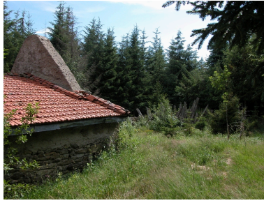
Vue d'ensemble depuis le nord-est. Phot. Caroline Guibaud IVR82_20124201476NUCA
