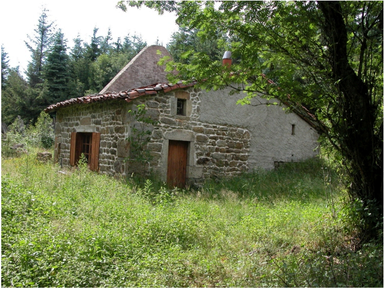
Vue d'ensemble de la seconde logette.
