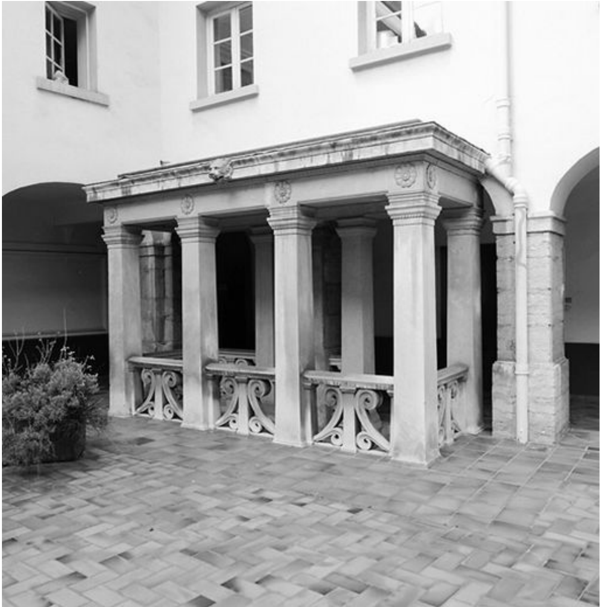
Vue générale du portique
