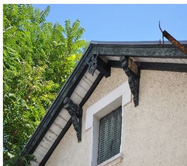
Avant-toit Phot. François Fouger IVR82_20117300597NUCA
