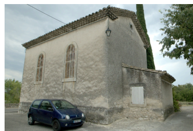
Élévation latérale droite et mur pignon auquel est adossée la sacristie.
