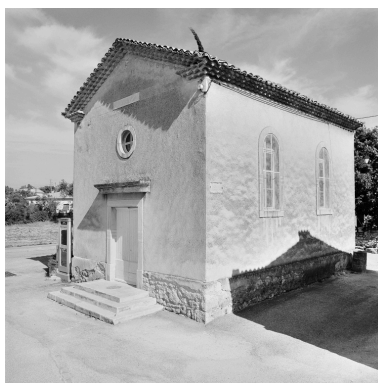
Vue d'ensemble de l'édifice, de trois quarts droite.
