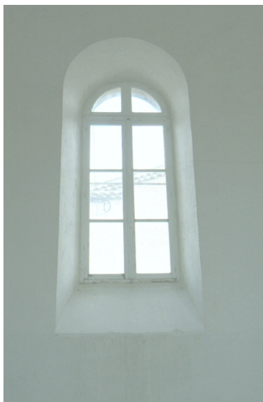
Vue de l'intérieur : fenêtre dans l'élévation latérale. Phot. Geneviève Jourdan IVR82_20102600580NUCA
