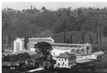
Vue générale des halles en 1924 Repro. François Fouger IVR82_20087300708NUCB
