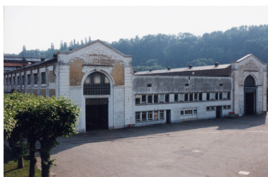
Pignons nord des halles A, B, C et D et du bâtiment E Repro. François Fouger IVR82_20087300700NUCB
