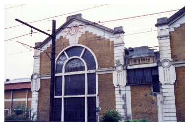
Pignon ouest de la halle Z Repro. François Fouger IVR82_20087300699NUCB
