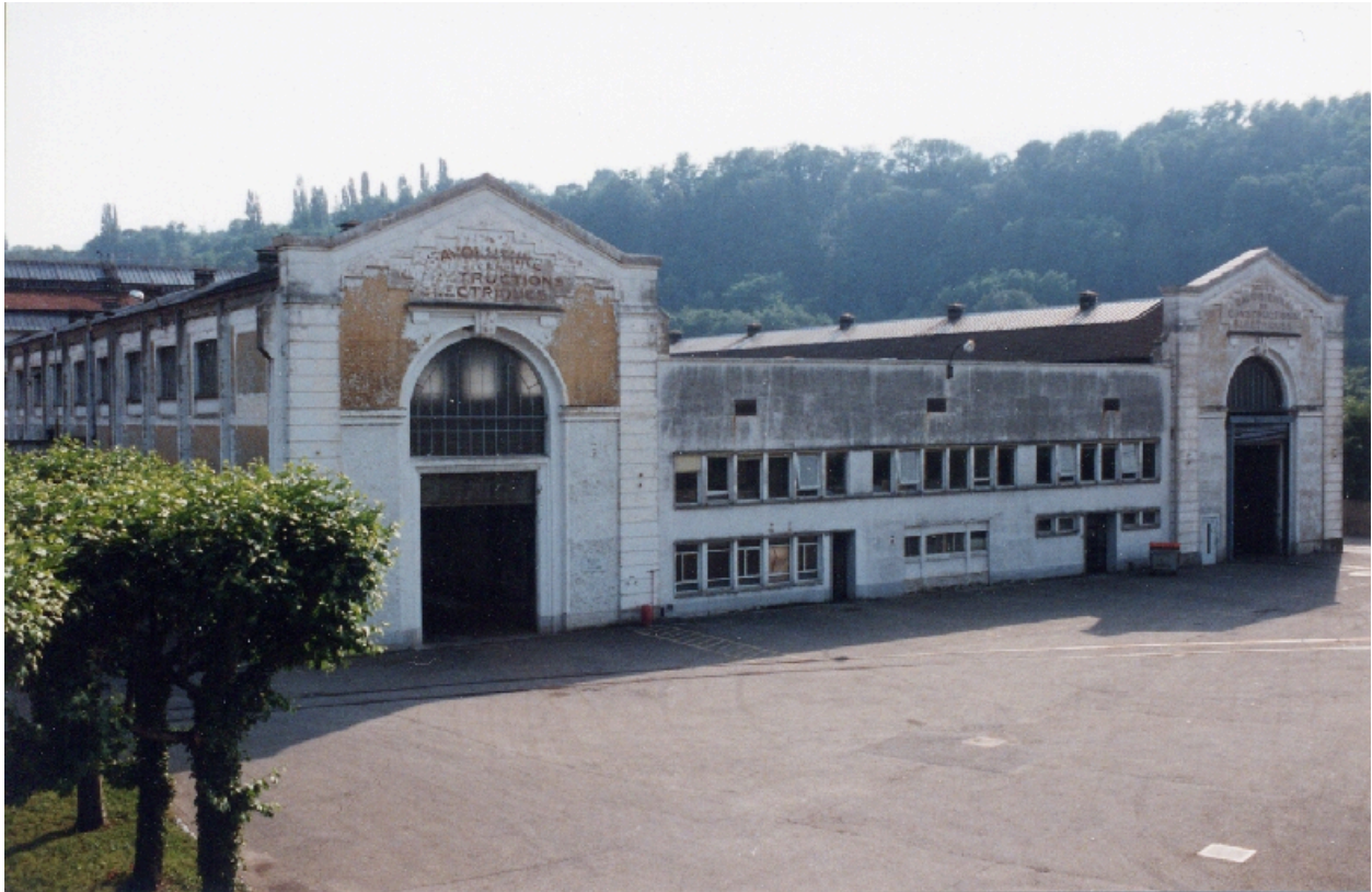
Pignons nord des halles A, B, C et D et du bâtiment E
