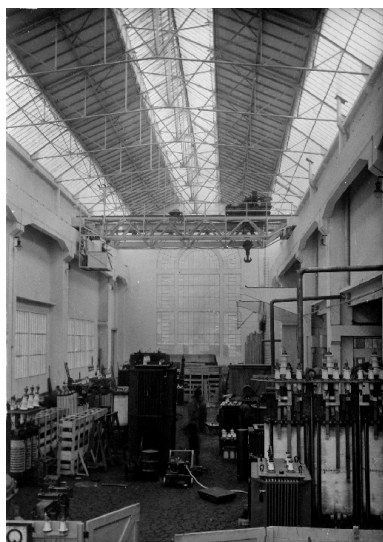
Intérieur de la halle Z Repro. François Fouger IVR82_20087300707NUCB
