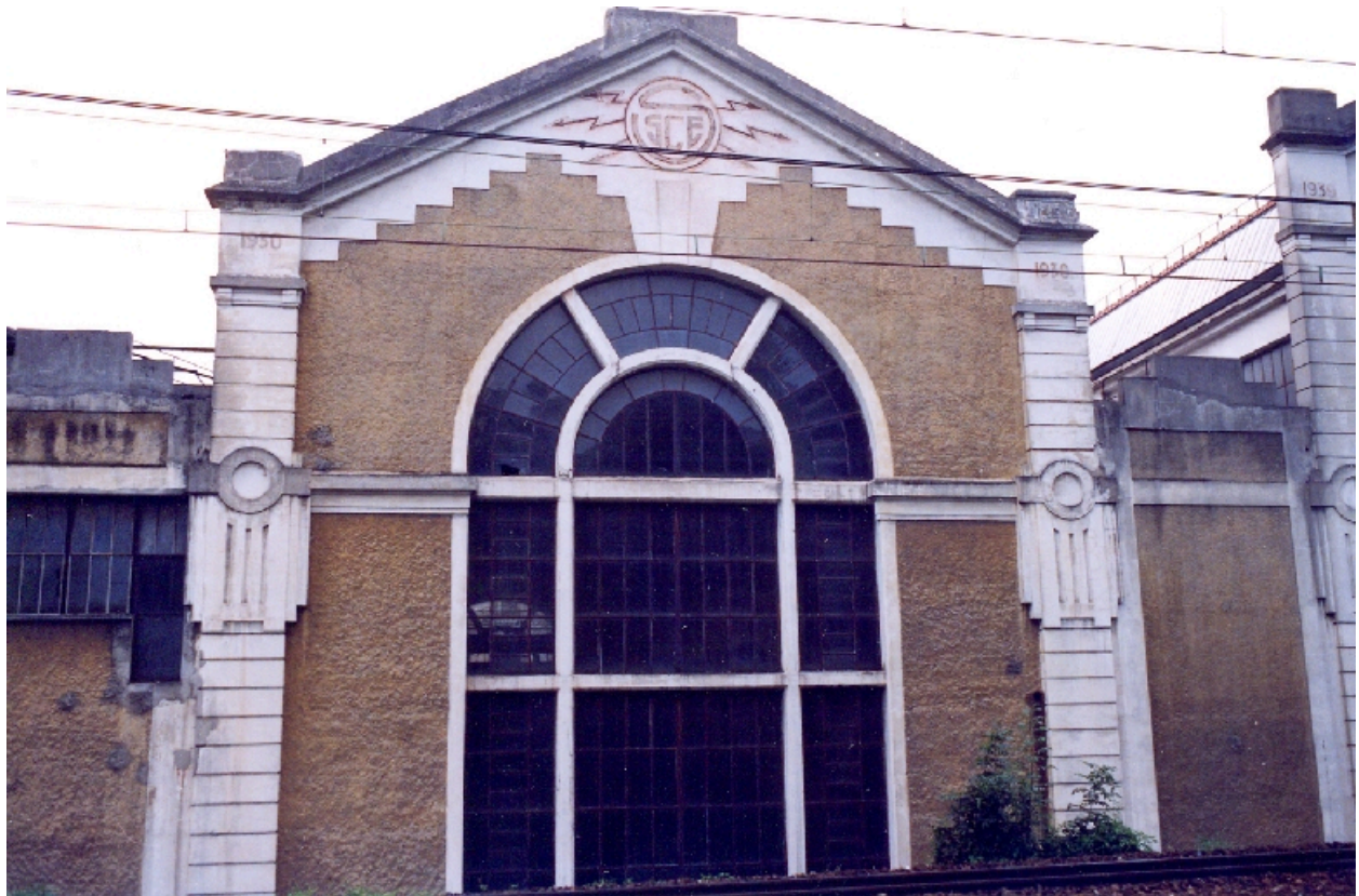
Pignon ouest de la halle Y
